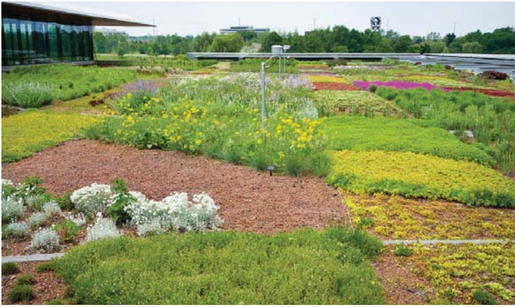
Imagen 18: Ejemplo de cubierta intensiva
