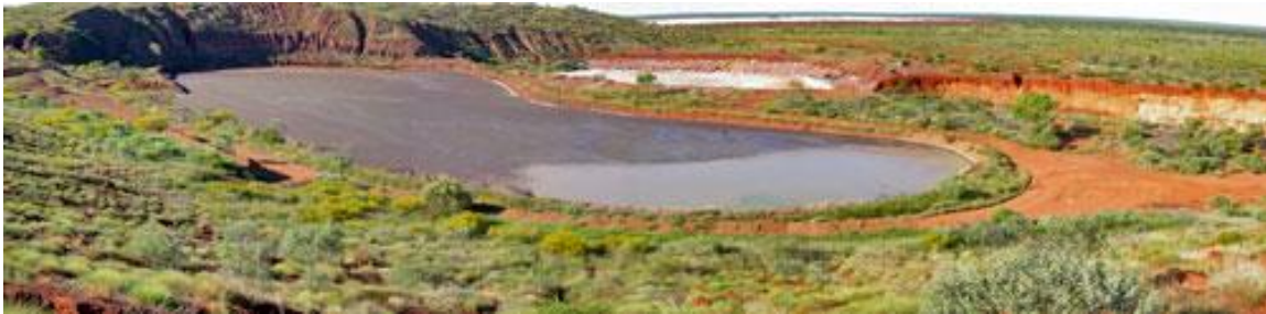
Figura 11. Jales como relleno en tajos (Tailings.Info, 2016).
