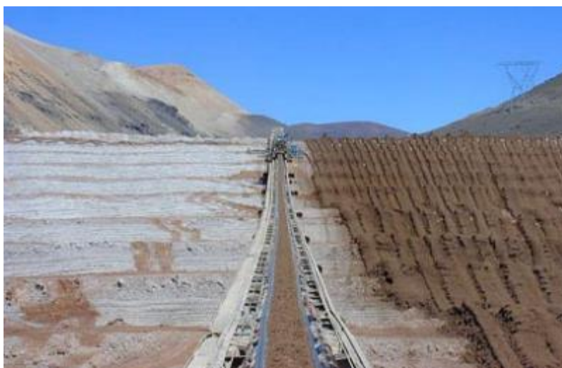
Figura 10. Depósito de jales secos La Coipa, Chile (Tailings.Info, 2016).
