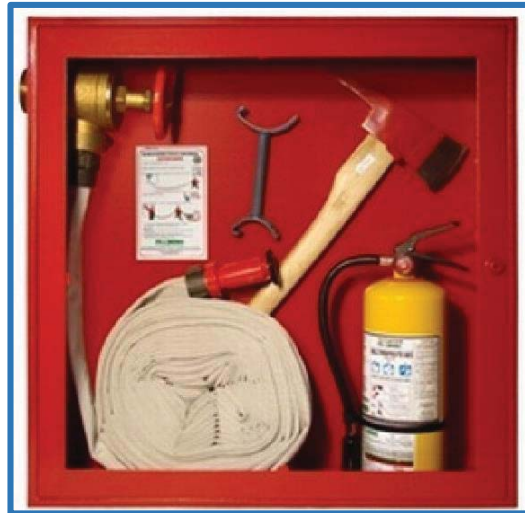
IMAGEN N° 21 GABINETE CONTRA INCENDIOS Fuente:www.vegusa.com.pe/detalle
