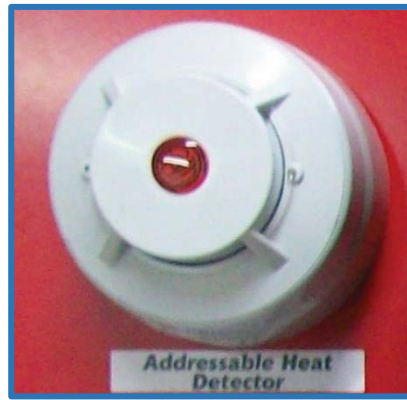
IMAGEN N° 26 DETECTOR DE CALOR Fuente: www.prefire.es/proteccion-contra-incendios
