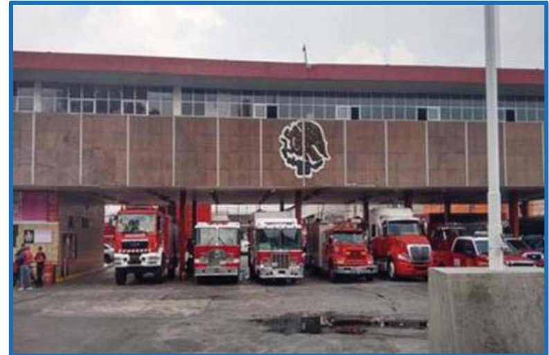
IMAGEN N° 36 FACHADA ESTACIÓN CENTRAL Fuente: www.bomberos.df.gob.mx/wb/hcb/estacion_central
