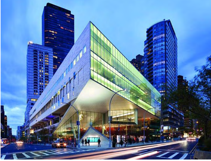
Nueva Fachada para Julliard School
