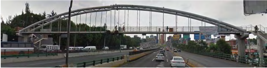
Figura 6.2 Imagen en elevación del puente.
