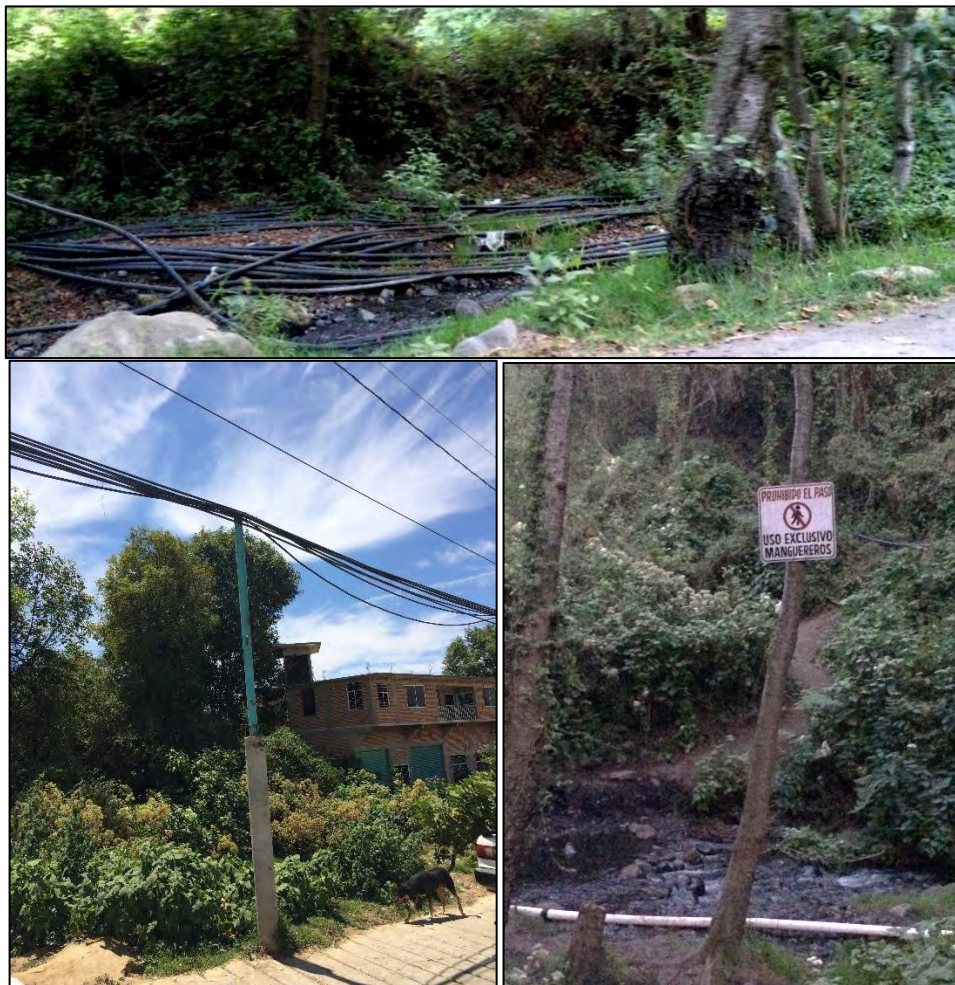
Imágenes 2, 3 y 4. Sistema de mangueras en Tetela del Volcán
