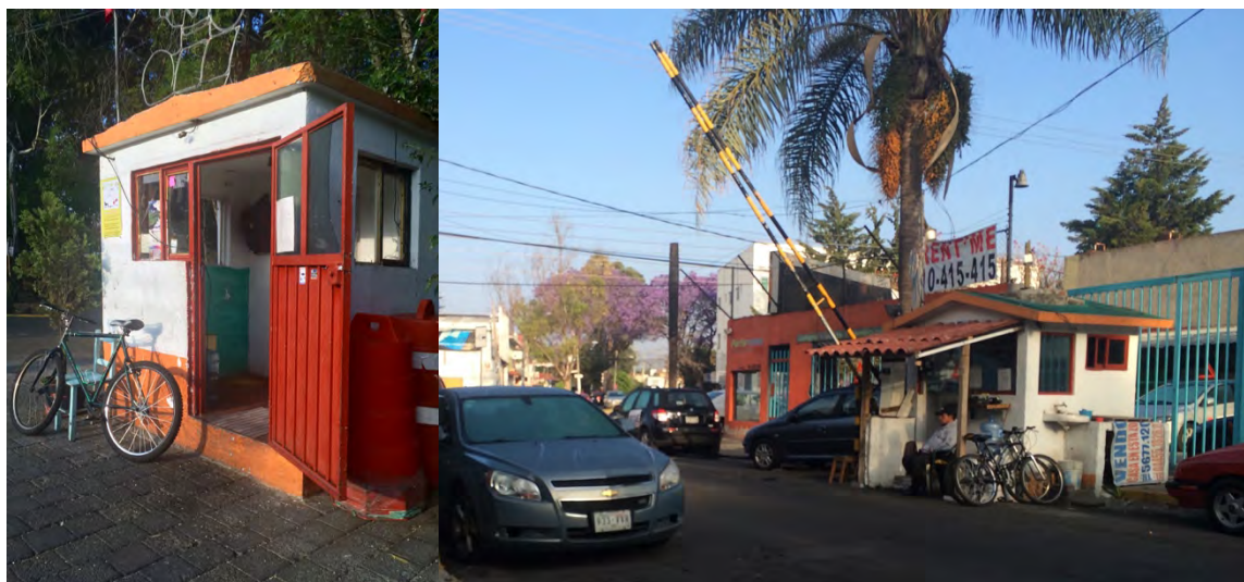
Fig. 38: Vista de las dos casetas de vigilancia que resguardan el sector
