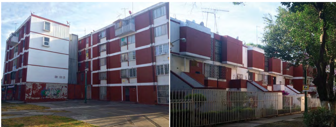
Fig. 32: Vivienda multifamiliar y dúplex en el CTM Culhuacán Sección II
