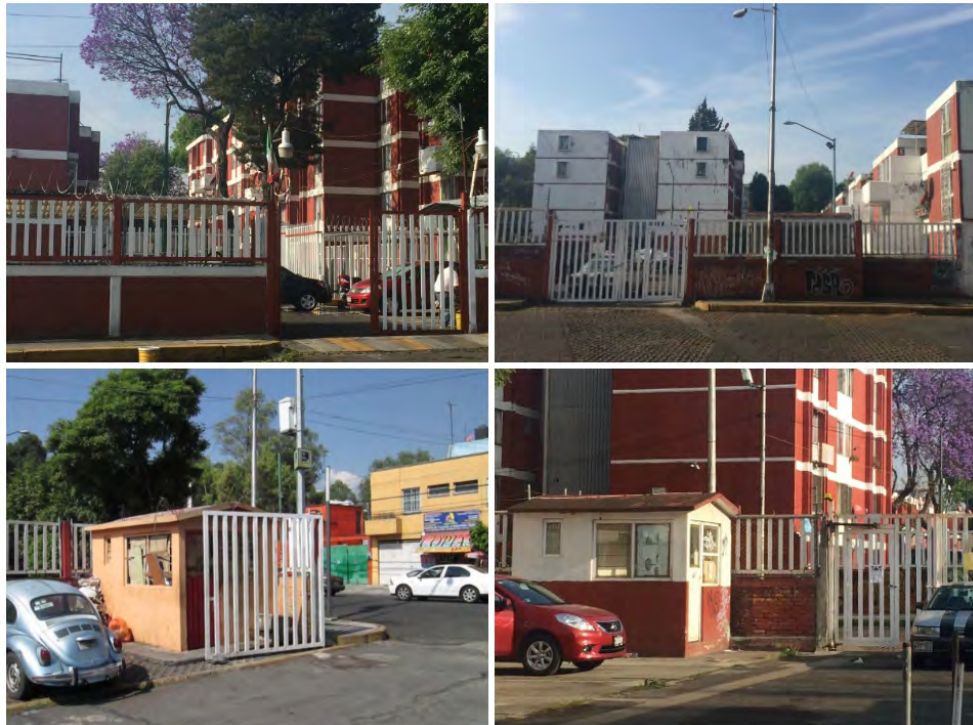
Fig. 45: Cierre perimetral y casetas de vigilancia en puntos de acceso del conjunto habitacional.
