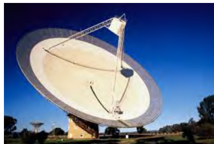
Figura 4.1: Telescopio Parkes localizado en New South Wales, Australia. Posee una antena parabólica con diámetro de 64 metros. Imagen obtenida de https://www.atnf.csiro.au/outreach/visiting/parkes/index.html .
