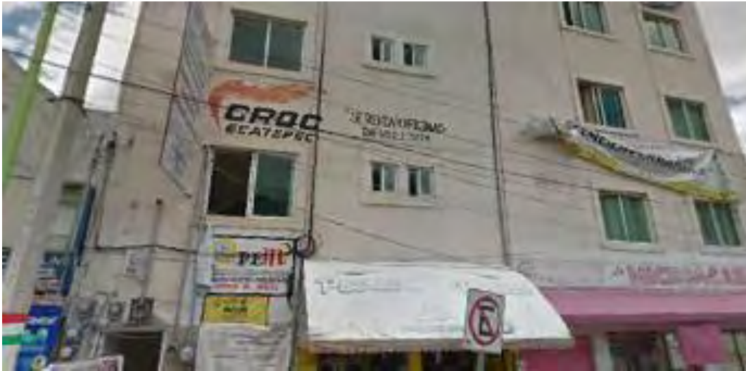
Plaza comunitaria de la CROC en San Cristóbal Centro
