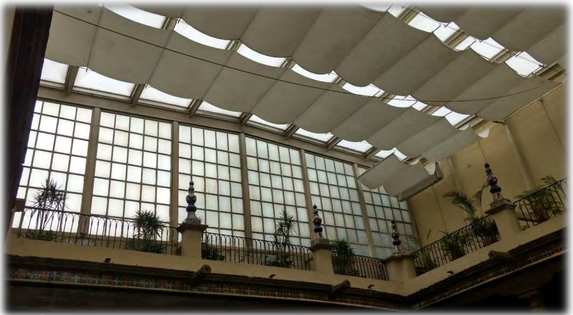
Domo de acero que cubre el patio principal de la casa
