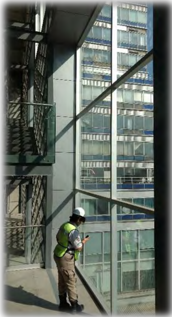
Ventanal de descanso en escaleras a cuarto piso
