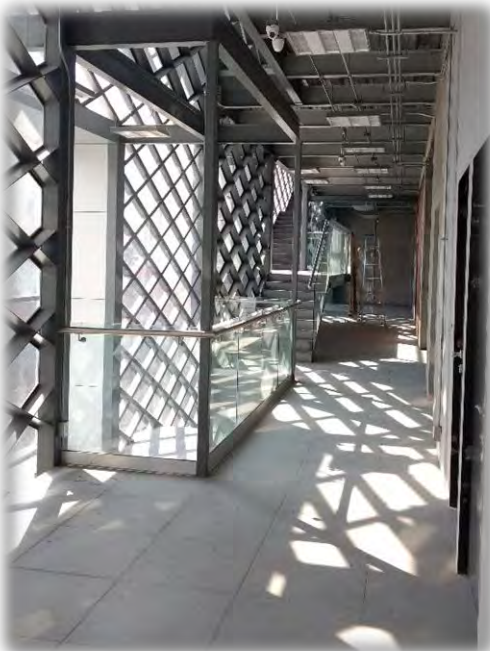
Pasillo tercer piso (baños, elevadores, bodegas, archivos, curto de instalaciones)
