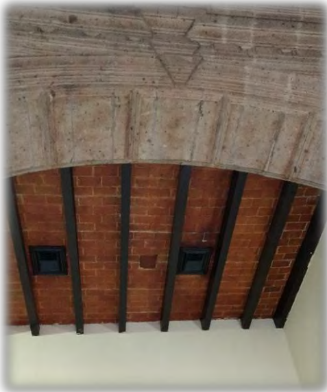
Bóveda catalana, terrado sobre vigas de madera
