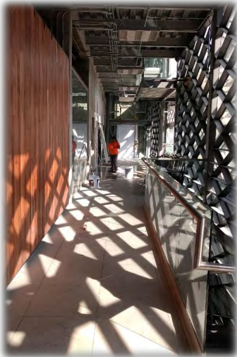
Pasillo de segundo piso (baños, elevadores, cuarto de instalaciones)
