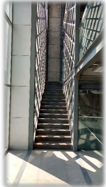
Escaleras a cuarto piso
