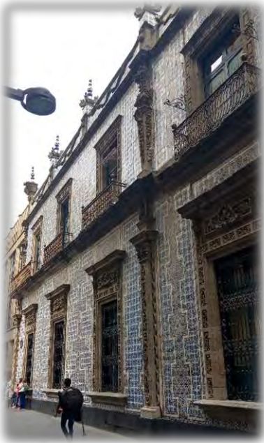
Pilastra que muestra la división entre la casa original de los azulejos y la parte que se agregó se encuentra por calle Condesa
