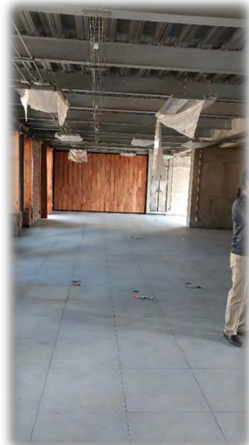
Área de agregado cultural de Colombia
