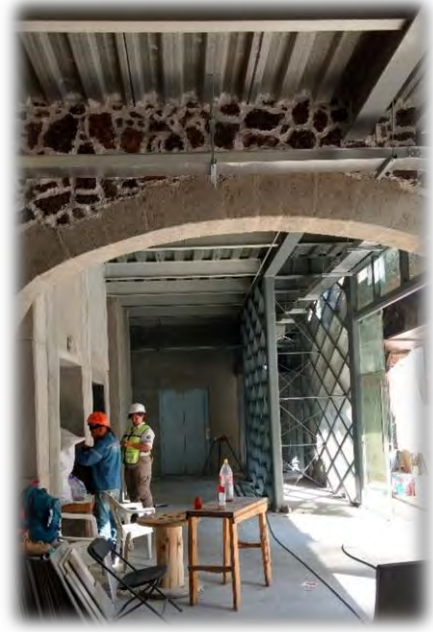
Planta baja, elevadores, detalle de mampostería conservado del inmueble original
