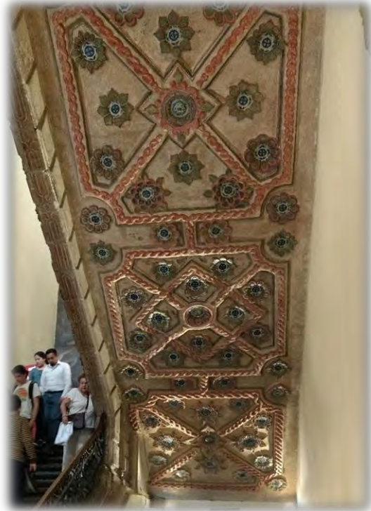
Detalle de cantera en pendiente de escaleras
