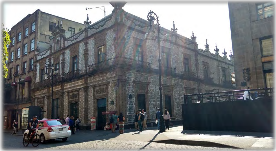
Vista de la casa por calle 5 de mayo
