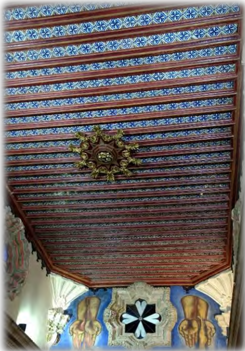
Bóveda catalana y terrado sobre vigas de madera con detalle de azulejo y cantera
