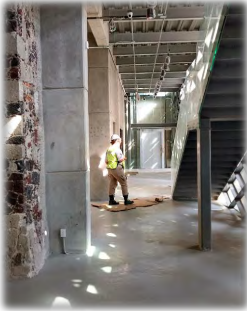
Pasillo de acceso galería
