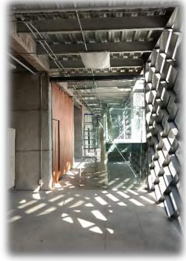
Pasillo tercer piso (elevadores, baños, bodegas, archivos, cuarto de instalaciones)
