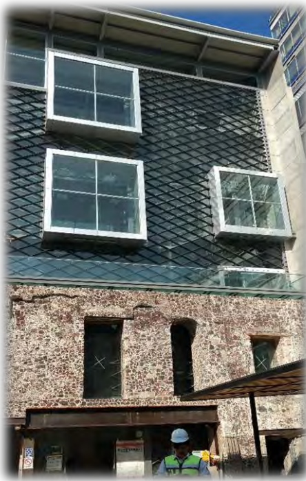
Fachada posterior del edificio
