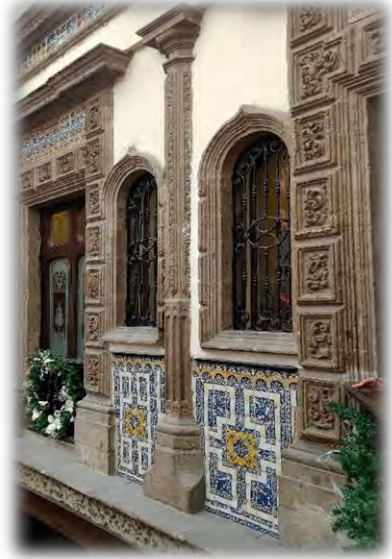
Detalle de cantera en muros, ventanales y ventanas
