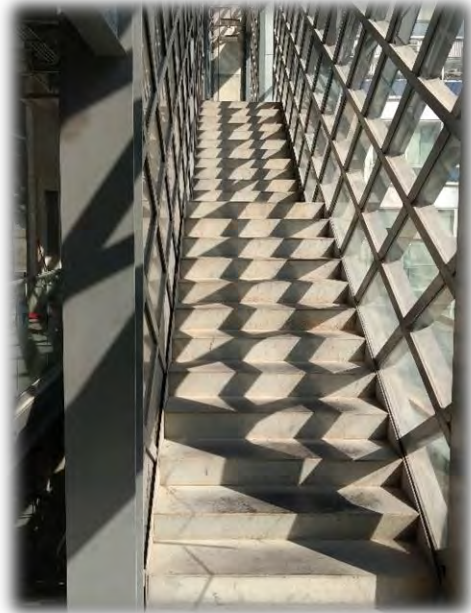
Escaleras de acceso a tercer piso
