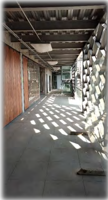
Pasillo de cuarto piso (elevadores, baños, archivo, cuarto de instalaciones)
