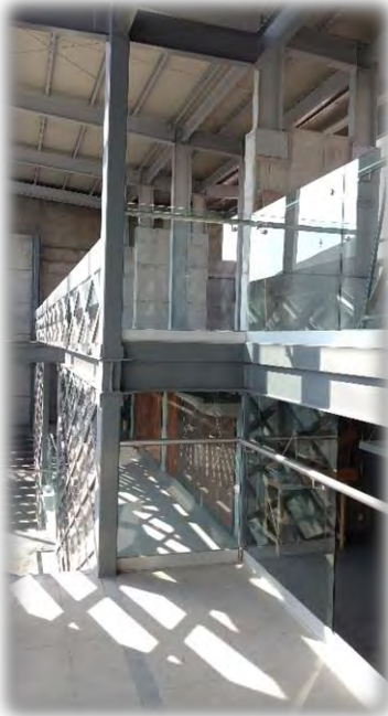
Descanso de escaleras a azotea
