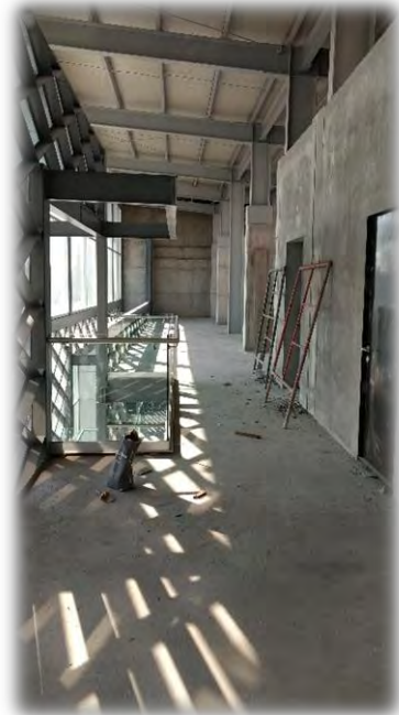
Pasillo de azotea (baños, escaleras, cuarto de instalaciones)
