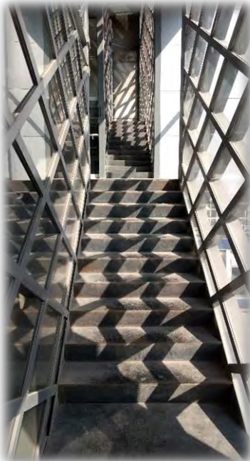
Escaleras a azotea
