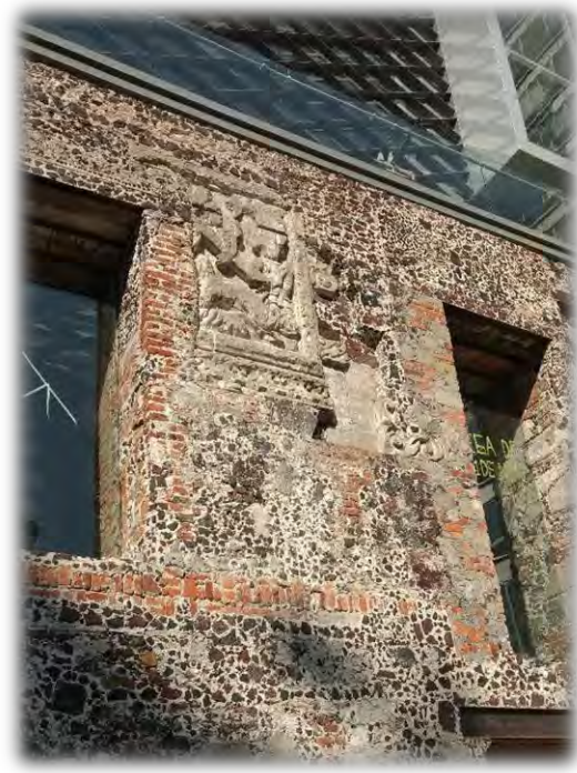
Detalle de cantera y muro de mampostería que se conservó del inmueble original
