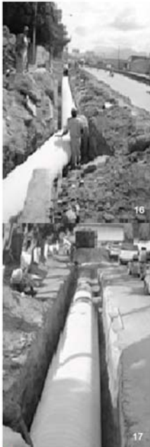
Fig.16, 17. Colocación de Drenaje Tomadas: Proporcionadas por el Municipio.
