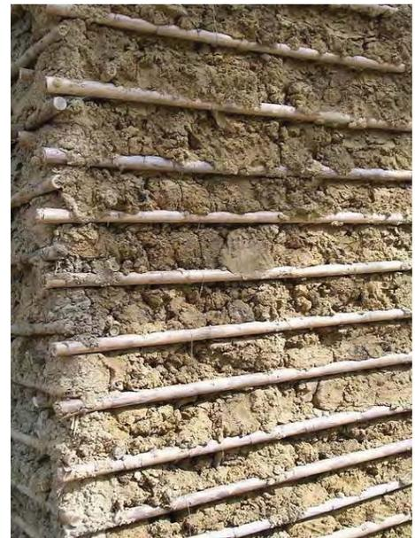
*Ilustración 21 Muro de Bahareque. Fabricado de otate y barro*
