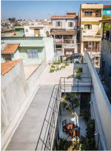
Foto 95. Intervención en la vivienda.
