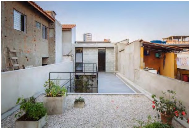
Foto 92, 93 y 94. Resultado de la intervención arquitectónica.
