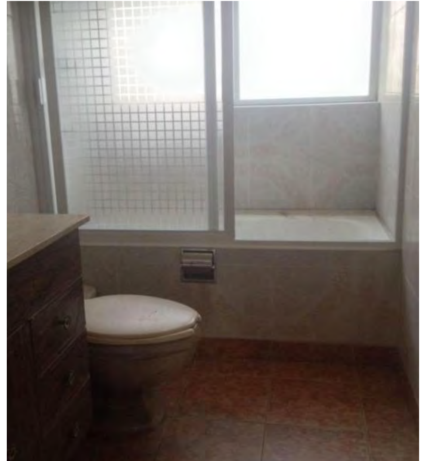
Foto 80. Vista del único baño del departamento.
