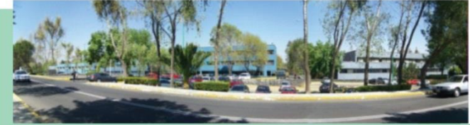
Figura 5.1.1.2 Edificios de Investigaciones en Humanidades Imagen de elaboración propia
