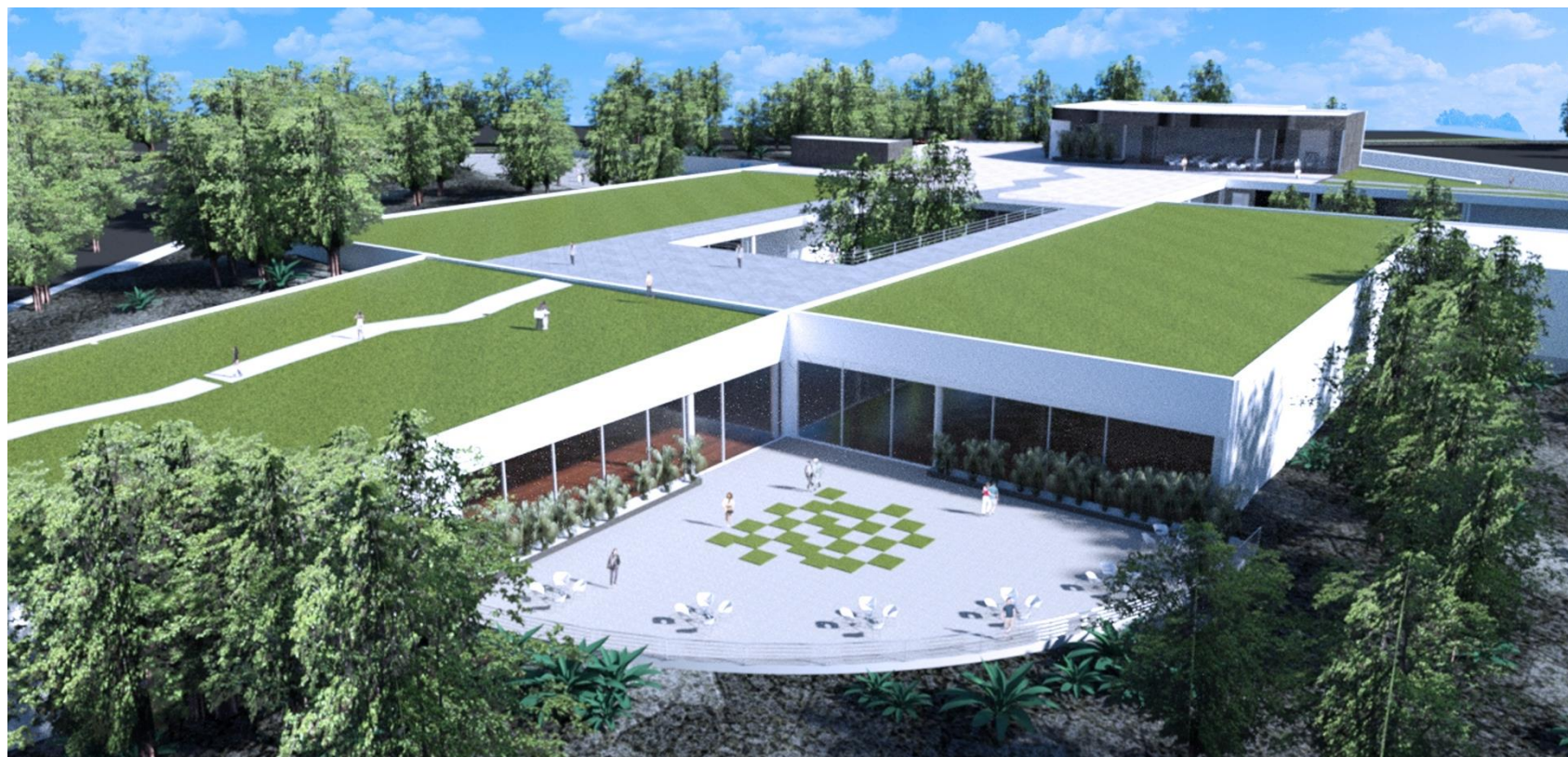
Figura 6.1.3 Vista sur del conjunto arquitectónico “Museo del Agua” Imagen de elaboración propia
