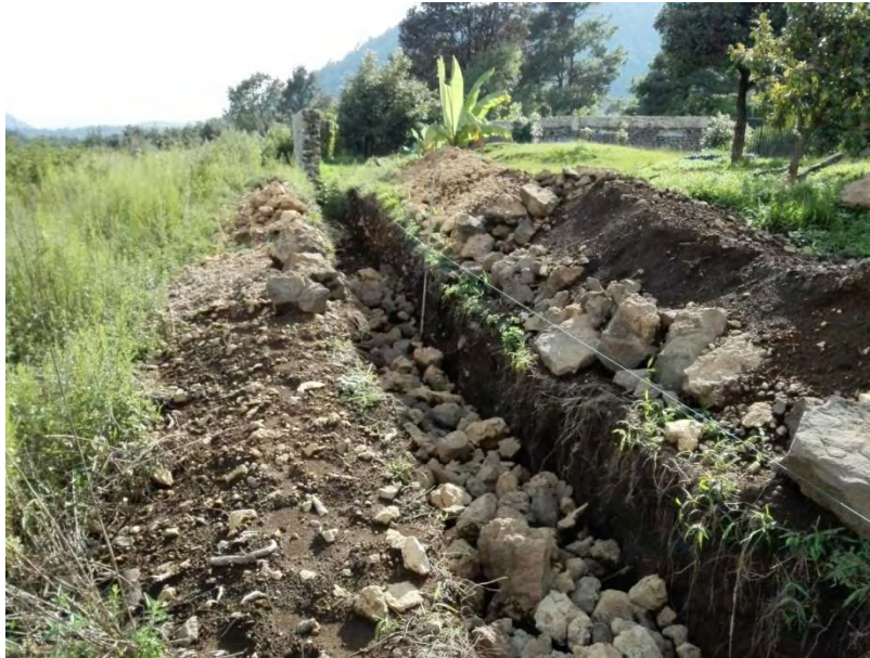
Fotografía 3.2 Zanja contigua al muro.
