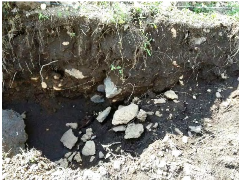
Foto 3.13 Excavaciones para el estudio de mecánica de suelos.
