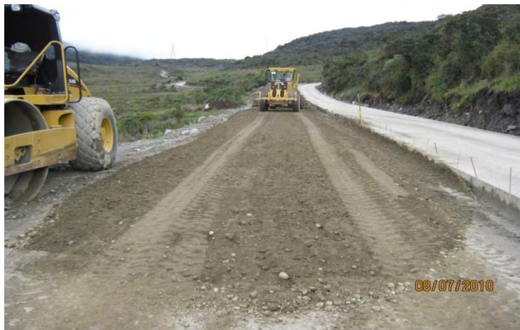
Imagen 2.6.- Construcción de la sub-base
