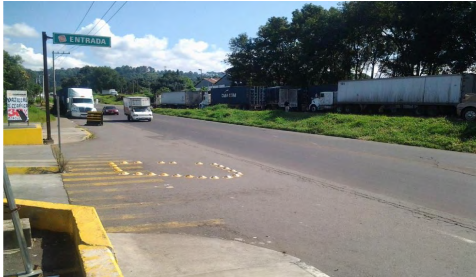
Imagen 3.9.- Tramo sin ampliarse.
