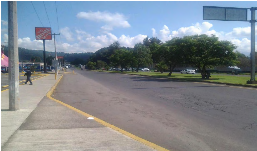
Imagen 3.6.- Vista de Sur a Norte del tramo en estudio.
