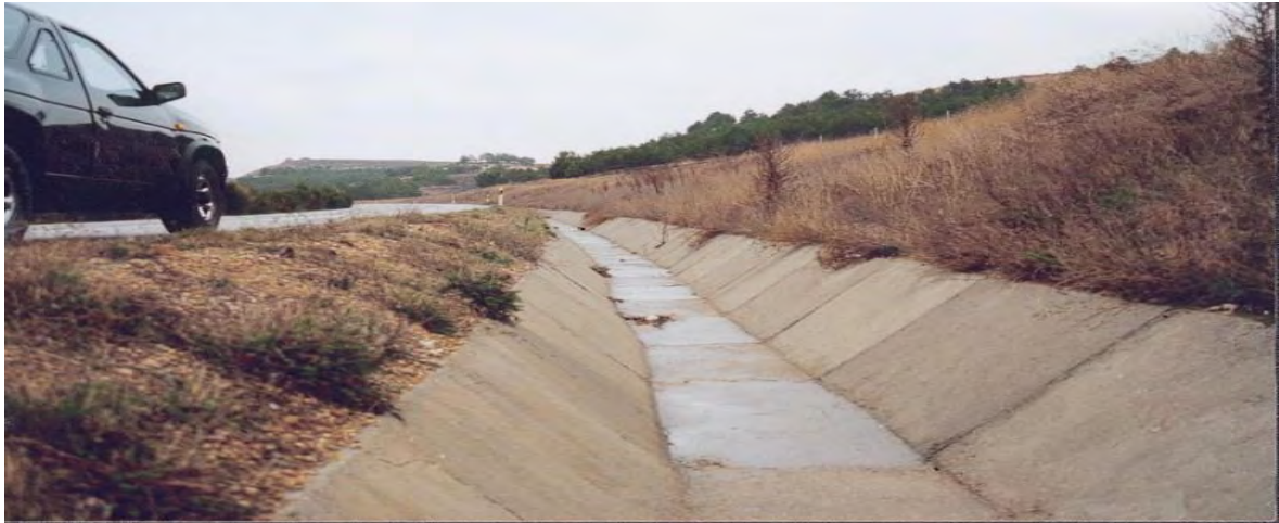
Imagen 2.3.- Cunetas en los costados de los caminos.
