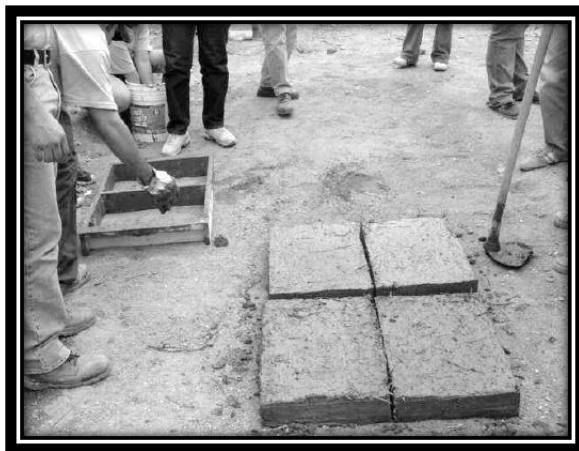
Imagen 2.3.- Piezas desmoldadas de adobe.
