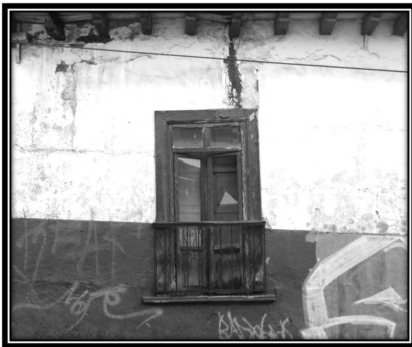
Fotografía 5.11.- Una de las 3 ventanas ubicada en la fachada de la calle Manuel Ocaranza.
