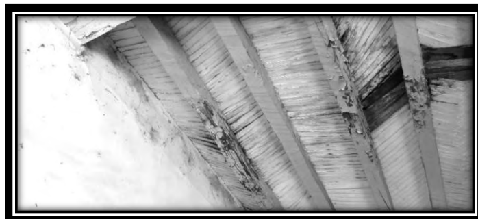
Fotografía 5.7.- Vigas en el pasillo de la entrada del inmueble.
