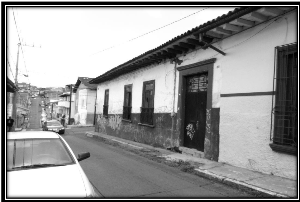
Fotografía 3.2.- Fachada principal en la calle libertad.
