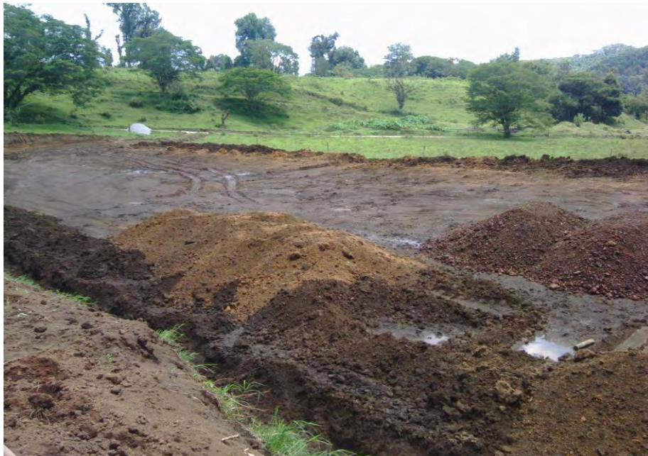
Figura6. Preparación del terreno.
