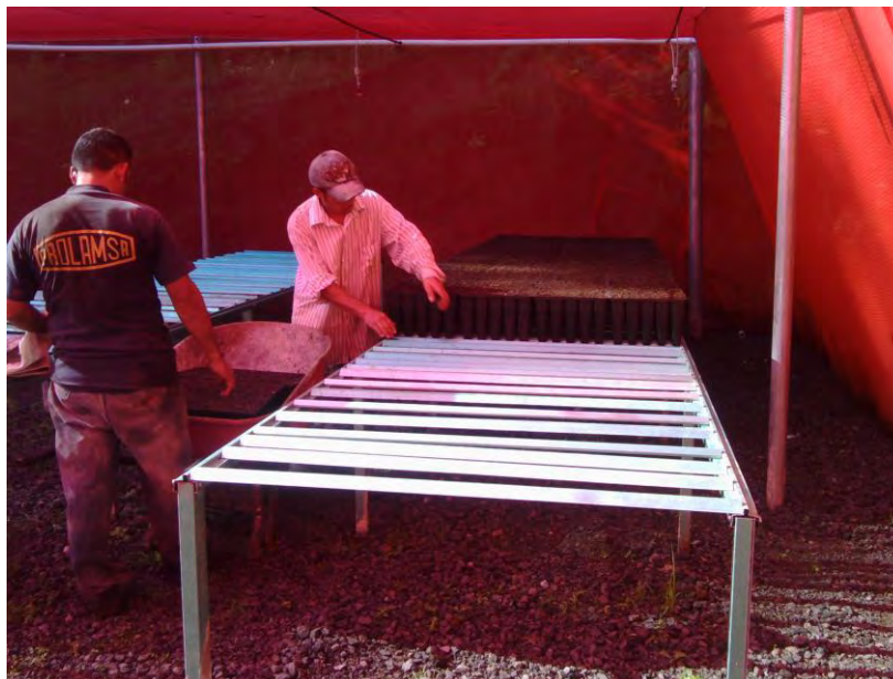
Figura 10. Colocación de perfiles para las mesas de trabajo.
