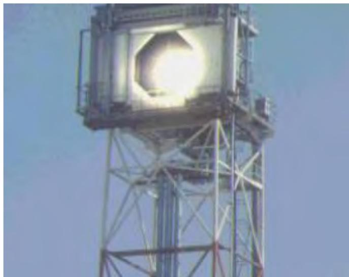
Figura 2.10. Pérdidas por desbordamiento en un receptor de torre central
