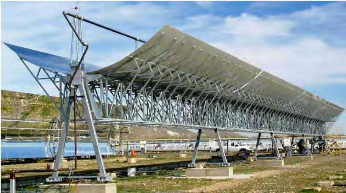
**Figura 3.8 Estructura de los colectores Eurotrough**
