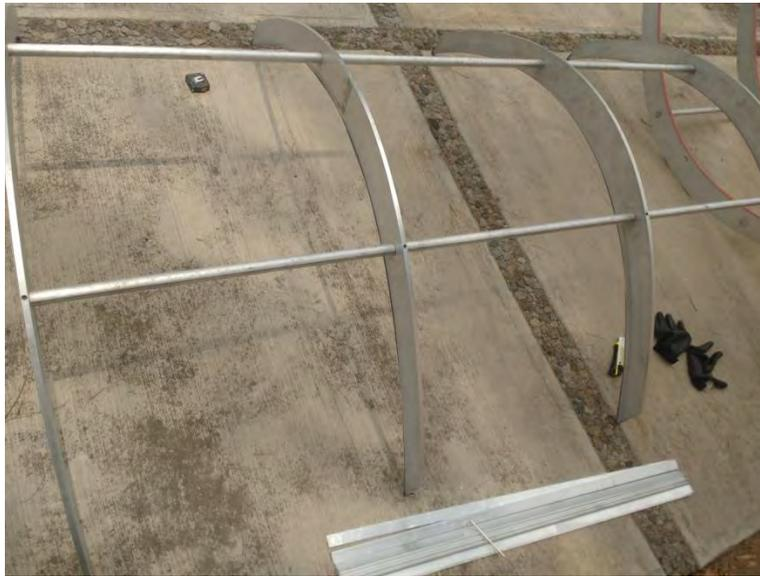
**Figura 4.5 Soportes parabólicos conectados entre sí.**
