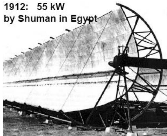
**Figura 3.4 Primera planta de generación de energía mediante colectores parabólicos en Maadi, Egipto,**
