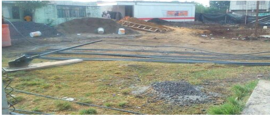
Imagen 2. La escuela Diego Rivera durante la construcción de las dos aulas (nótese que ya cuenta con una explanada de cemento).
