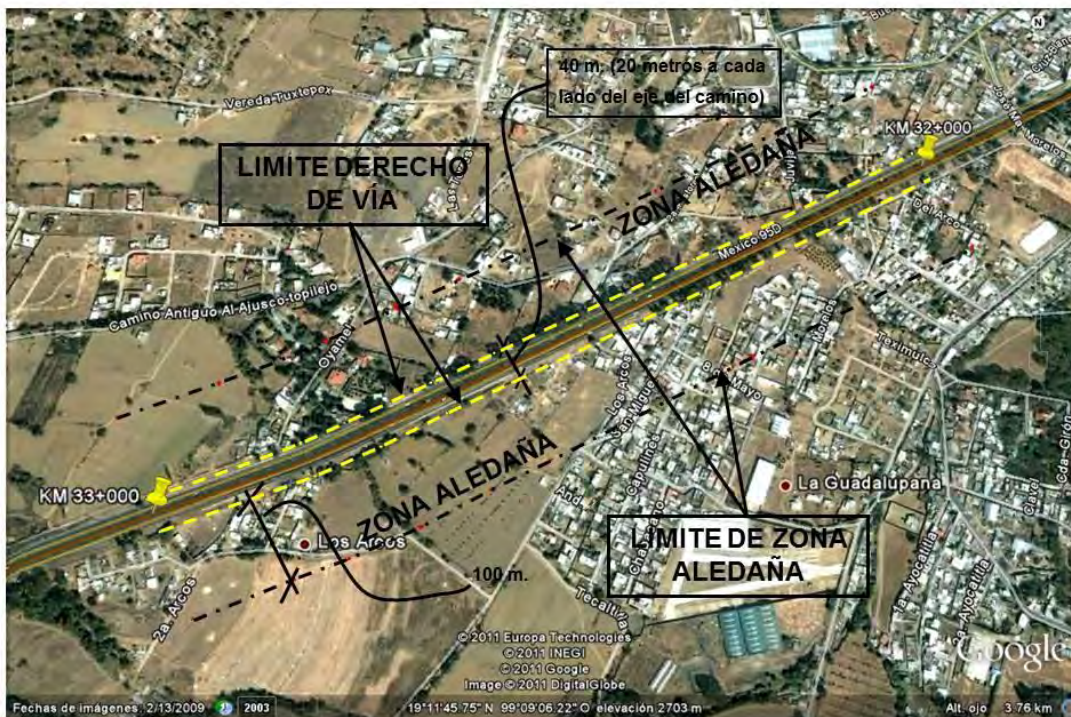
FIGURA No. 3: DERECHO DE VÍA Y ZONA ALEDAÑA ENTRE EL KM 32+000 Y 33+000, AUTOPISTA MÉXICO-CUERNAVACA
