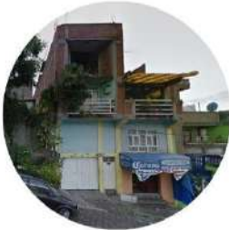
4. Vivienda autoconstruida 4 niveles
