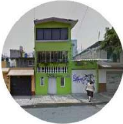
3. Vivienda autoconstruida 3 niveles
