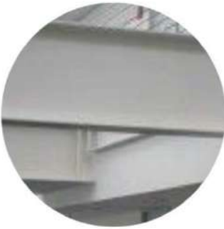
Estructura metálica aparente, acabado color blanco mate
