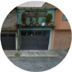
2. Vivienda autoconstruida 2 niveles
