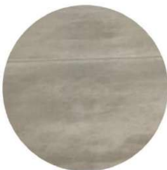
Capa de compresión de concreto con acabado pulido.
