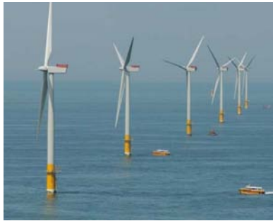
(c) Cimentación de aerogeneradores
