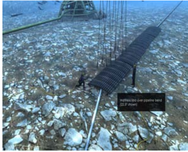
(a) Anclajes de conductos
