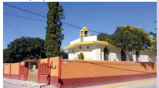
▲ Templo Metodista ubicado en la calle de Zaragoza, Tequixquiac.
