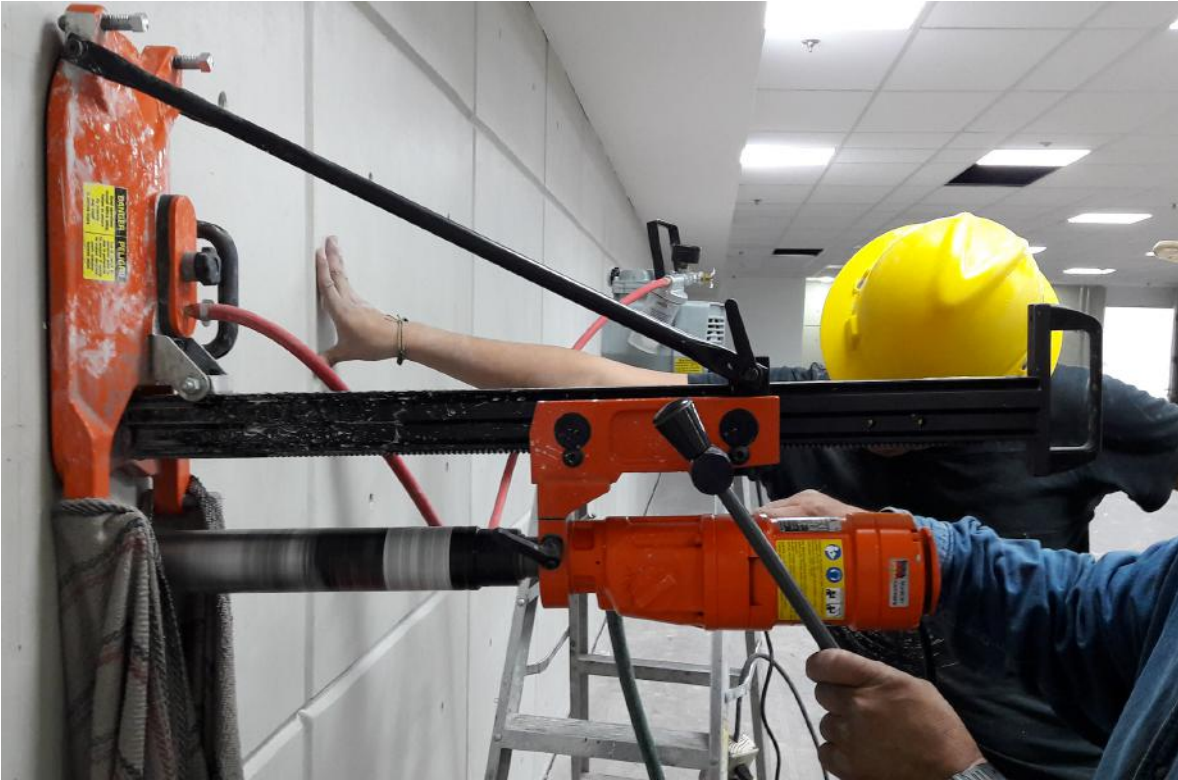
Figura 14: Extractora en operación.
