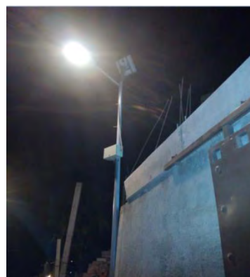
FIGURA 6.1.8 LUMINARIO PÚBLICO AUTÓNOMO SOLAR UBICADO EN EL MUNICIPIO DE IXTAPALUCA. ESTADO DE MÉXICO. SOFIA LEYVA. 2016
