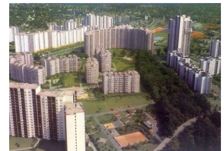
Viviendas Estado diseñadas por W. Gropius, en Berlín; Alemania entre 1962-1974. [2]
