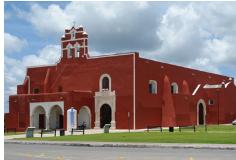
F 27 Ex convento de San Francisco de Campeche (fundación inicial extramuros)
