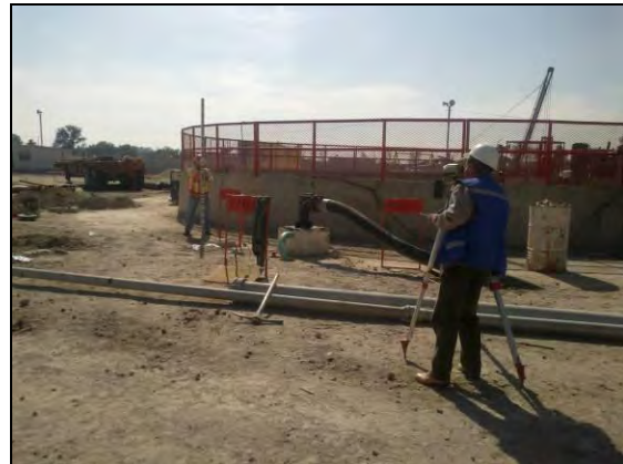
FOTOGRAFIA 02 Monitoreo de puntos de control con nivel electrónico.
