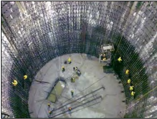
FOTOGRAFIA 30. Habilitado y armado de acero de refuerzo para la losa de fondo y el revestimiento definitivo de la Lumbreira.
