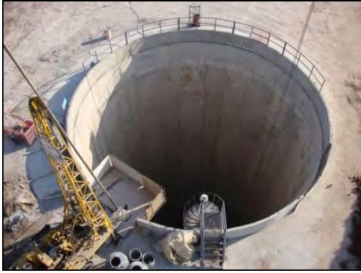
FOTOGRAFIA 24. Instalación de Inclínómetros en Muro Milán, para ello fue necesario colocar una plataforma para trabajar con mayor seguridad.
