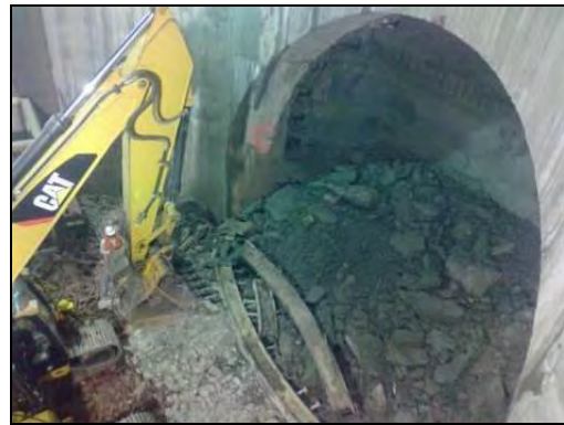
FOTOGRAFIA 36. Demolición de concreto y retiro de marcos metálicos en portal de entrada. Inicia construcción de Túnel.
