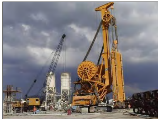
FOTOGRAFIA 17. Ensamble del equipo de perforación continúa para Muros Milán “Hidrofresa”.
