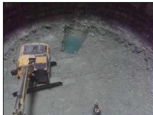
FOTOGRAFIA 23. Durante los trabajos de excavación del núcleo de presentaron algunos lentes de agua, los cuales fueron canalizados hacia un cárcamo para el bombeo de achique.
