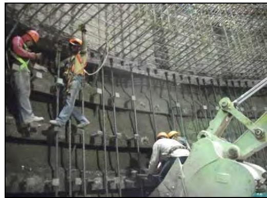
FOTOGRAFIA 27. Construcción de la Lumbraera bajo método convencional; en esta se aprecia la colocación de Marcos de acero, recubrimiento primario con concreto lanzado y preparaciones para el armado de acero del revestimiento definitivo.
