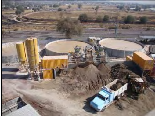
FOTOGRAFIA 18. Equipo auxiliar de "Hidrofresa": planta desarenadora, planta mezcladora, separador de finos, decantadores y planta de floculación.
