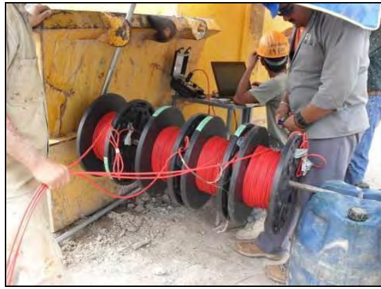
FOTOGRAFIA 11. Durante la instalación se toman registros con el Data Logger para verificar su correcto funcionamiento.
