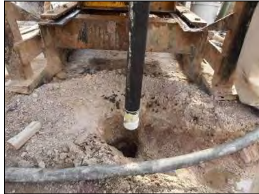
FOTOGRAFIA 13. Colocación de la tubería ranurada (forrada con filtro geotextil) dentro de un barreno libre a 145m de profundidad.
