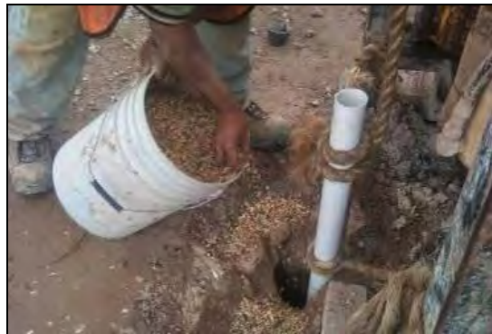
FOTOGRAFIA 14. Colocación de filtro de arena sílica.
