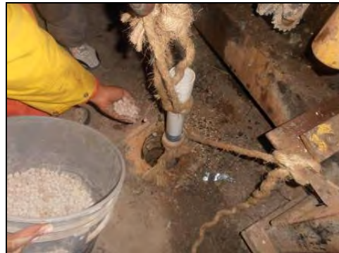
FOTOGRAFIA 07. Colocación de sello de bentonita (bolas de bentonita).
