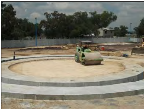
FOTOGRAFIA 16. Construcción de brocal exterior, mejoramiento del suelo del brocal interior para evitar asentamientos del suelo producidos por el peso de la excavadora “Hidrofresa”; con ello se pretende garantizar la verticalidad de los tableros.
