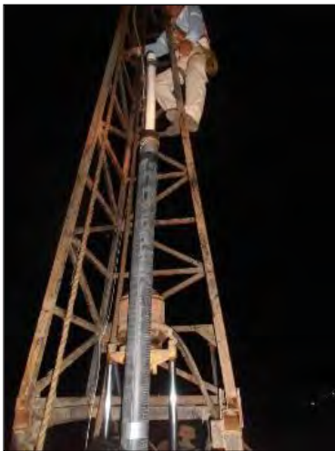
FOTOGRAFIA 06. Colocación de cámara piezométrica extendida.
