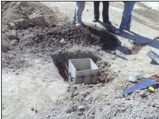
FOTOGRAFIA 01. Construcción de puntos de control para verificar si existen asentamientos en la periferia de la Lumbrera.
