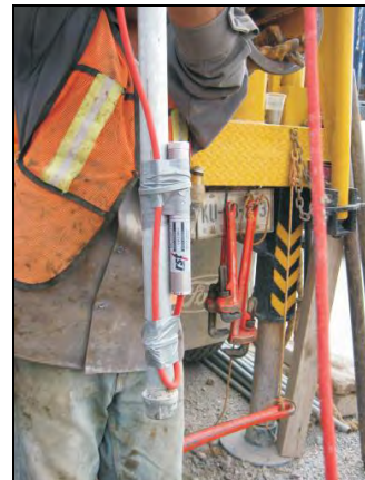
FOTOGRAFIA 09. Instalación de piezómetro eléctrico; se adosa a tubería guía para garantizar la profundidad de instalación.
