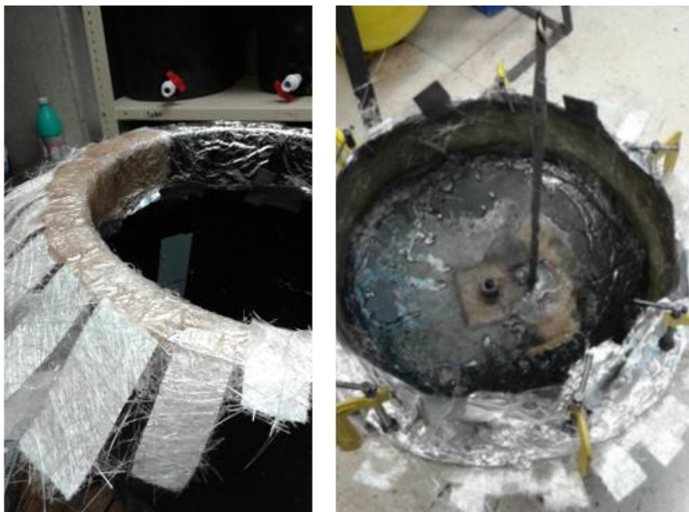
Figura 2.5. Reparación de una tapa empleando fibra de vidrio.
