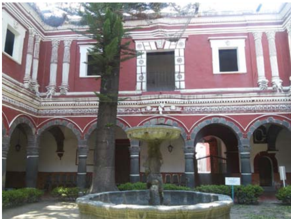
47. Interior del claustro del Hospital
