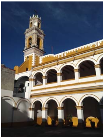
42. Vista de la torre desde el claustro
