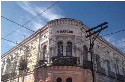
72. Detalle de la fachada principal
