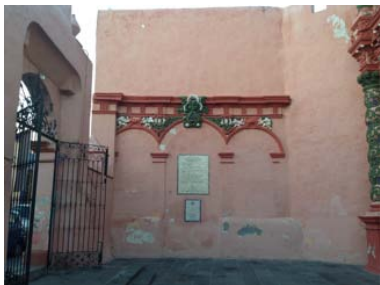
29. Acceso que comunicaba el atrio con el convento desaparecido.
