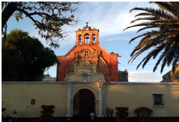
49. Vista de la capilla desde la Av. Hidalgo
