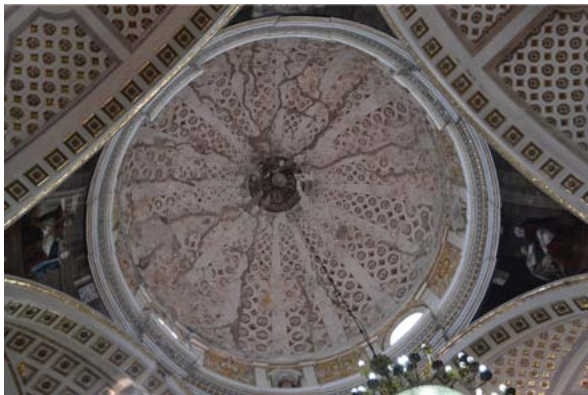
22. Vista interior de la cúpula
