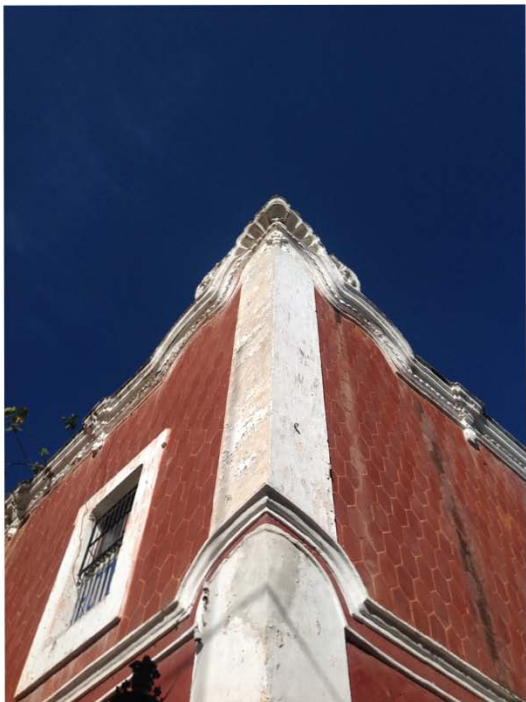
58. Detalle de la cornisa
