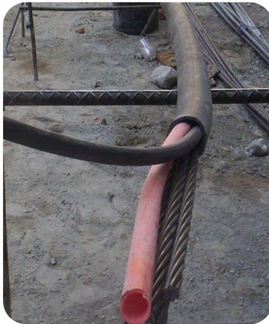
Figura 11. Tubos o mangueras de inyección y de retorno
