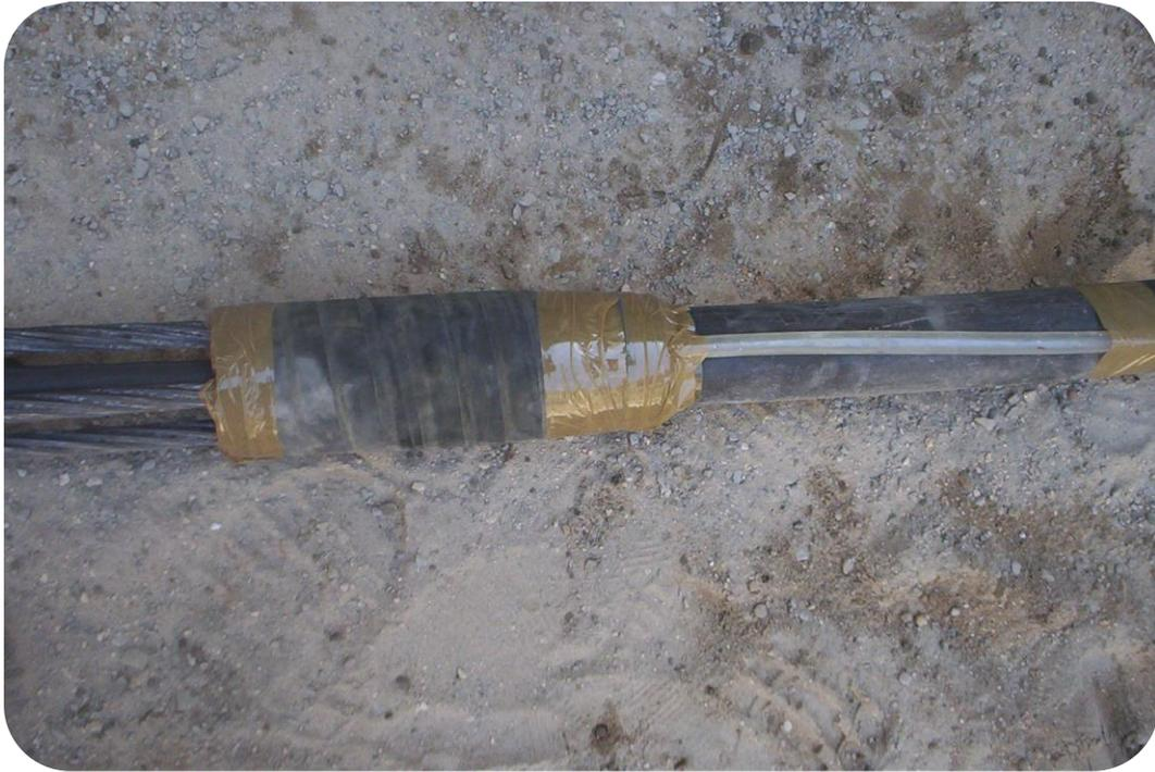
Figura 12. Obturador instalado con su manguera de aire
