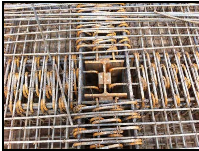
Ilustración 65. Capiteles construidos en planta baja y sótano comercial.
