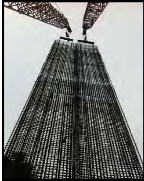
Ilustración 29. Izaje de dos paneles del muro Milán.
