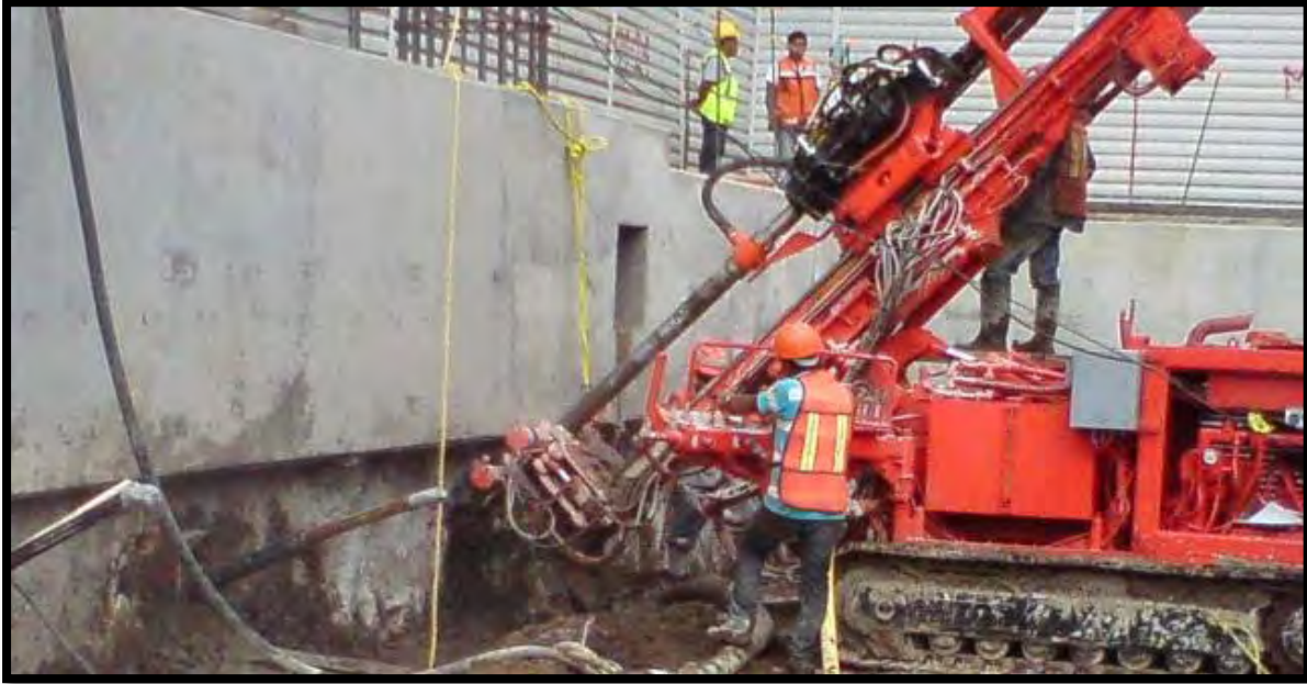
Ilustración 47. Perforación de anclas.
