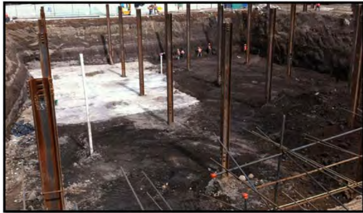
Ilustración 51. Perfil pre-cimentados en pila de cimentación con nivel de losa y perfiles en la primera fase de excavación.
