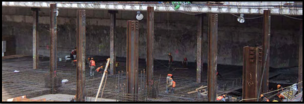
Ilustración 58. Armado sótano comercial.
