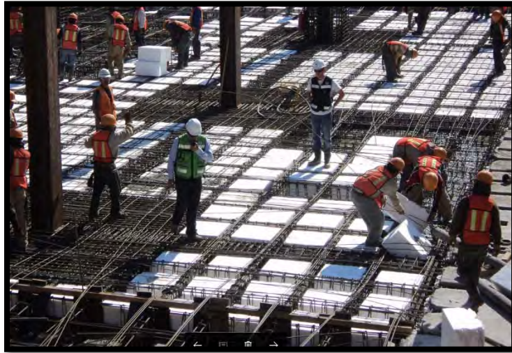
Ilustración 60. Colado de losa con nervadura.
