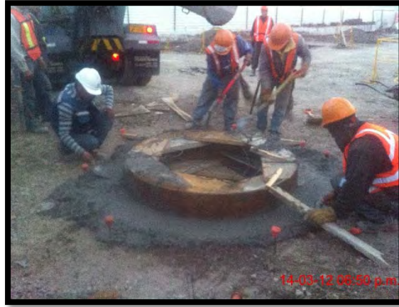
Ilustración 34. Brocal terminado de colar del proyecto Mítikah.
