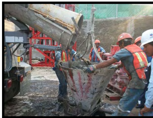
Ilustración 42. Colado de pilas.
