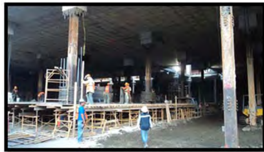
Ilustración 59. Armado y cimbrado de sótano dos.
