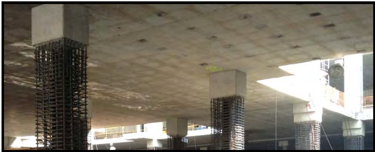
Ilustración 57. Muñón de columna terminada de losa sótano dos.
