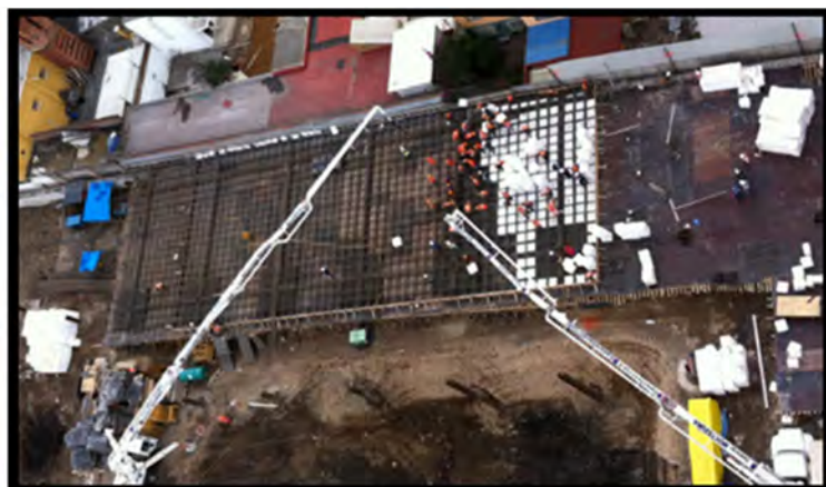
Ilustración 52. Colado de Planta Baja.
