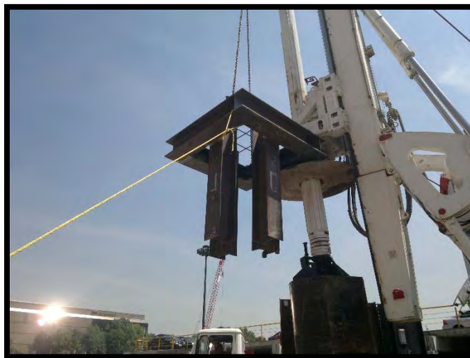
Ilustración 39. Guía de tubo de 30".
