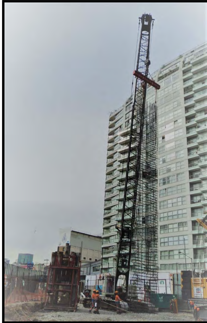
Ilustración 28. Empleo de balancín con dos puntos de izaje para el manejo de armados.
