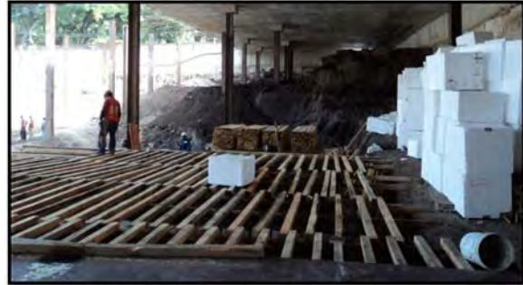
Ilustración 56. Cimbrado de la losa de los sótanos.
