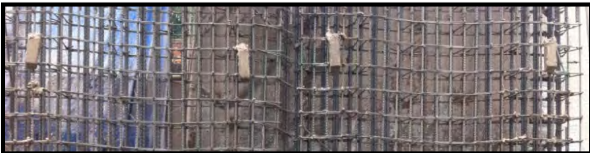
Ilustración 30. Muertos que garantizan el recubrimiento en el muro Milán.
