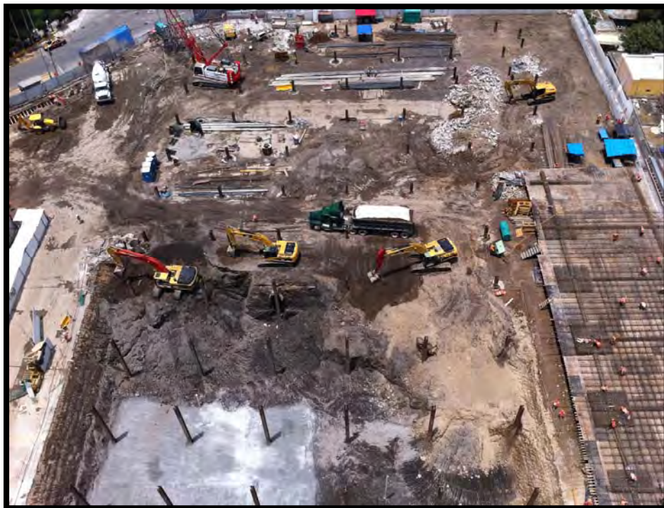
Ilustración 53. Logística inicial de excavación en Top - Down.
