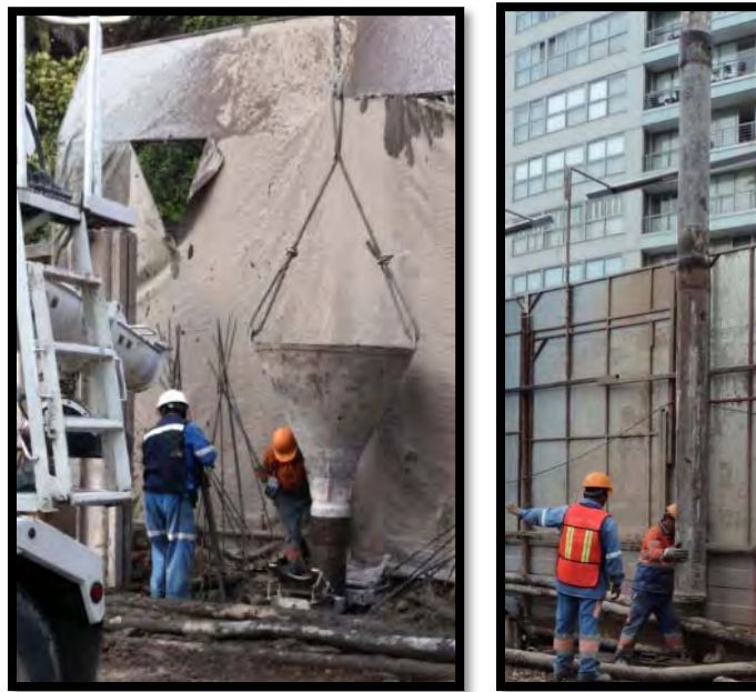
Ilustración 31. Colado con tubería tremi del muro Milán.
