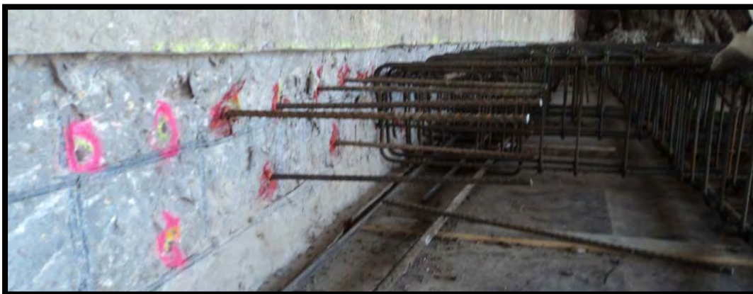
Ilustración 67. Anclaje de losa al muro Milán en losa de sótanos.
