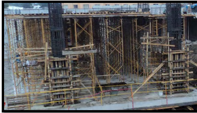
Ilustración 62. Armado y cimbrado de columnas.
