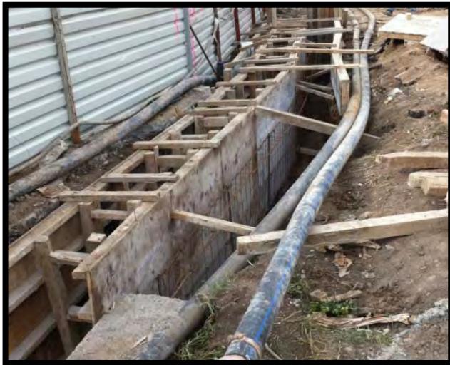
Ilustración 23. Construcción de brocales y detalle de brocal.
