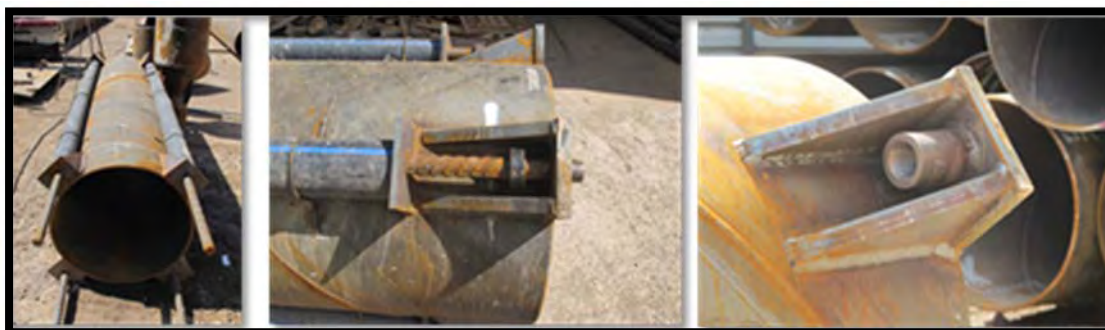
Ilustración 40. Protección a las varillas con espuma y mangueras.
