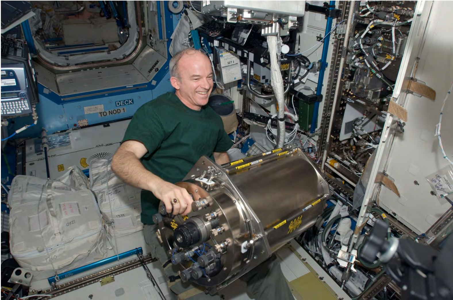
Anexo 13. El astronauta Jeff Williams instalando un filtro en el “Urine processing assembly” a bordo de la ISS.
