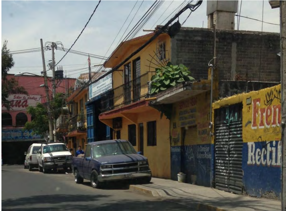
Fig. 48 Adición de niveles
