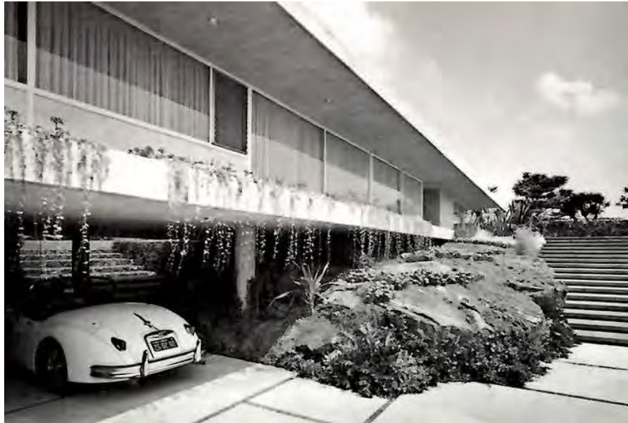
Fig. 29 Fachada de acceso. Fuente: unavidamoderna.tumblr.com
