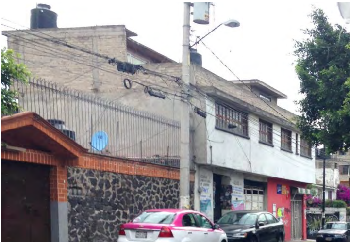
Fig. 59 Piedra volcánica, ladrillo rojo recocido y block, Pedregal de Santo Domingo.
