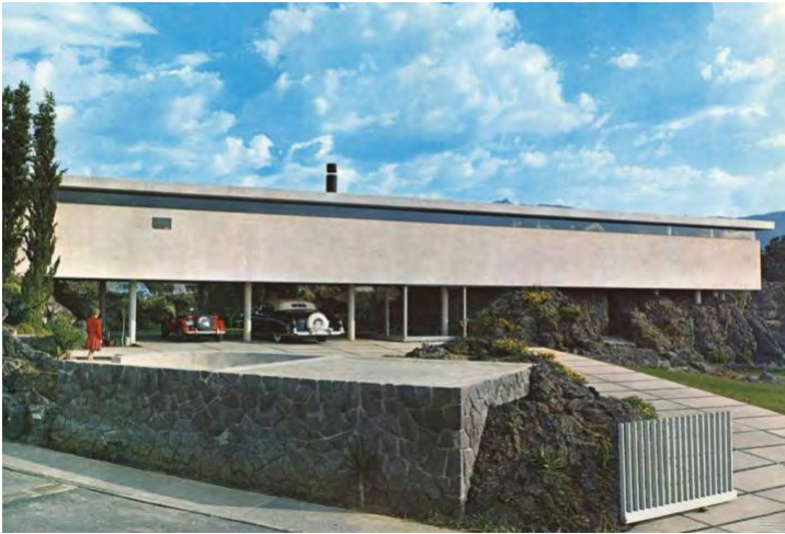
Fig. 58 Casa Stanley Wasun (1957), Jardines del Pedregal. Fuente: placesjournal.org
