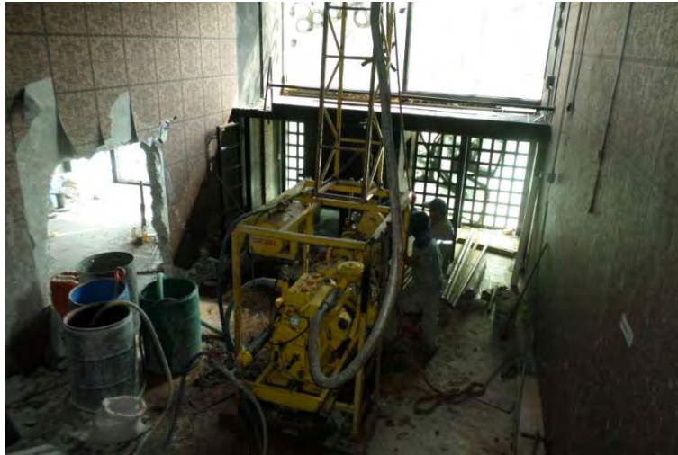
FOTOGRAFÍA 8. EQUIPO LISTO PARA LA PERFORACIÓN
