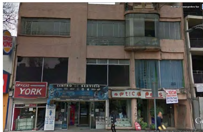
FOTOGRAFÍA 3. COLINDANCIA AL SUR
