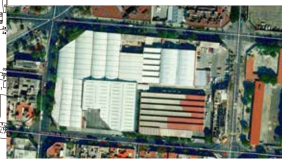
Existen grandes naves industriales que en su mayoría son fábricas con grandes áreas de carga y descarga.
