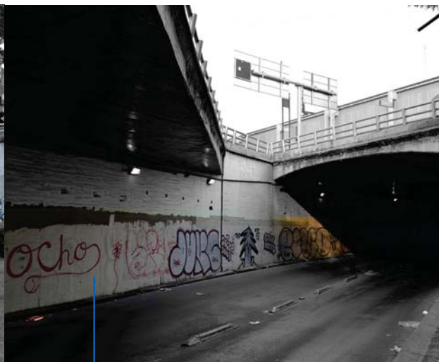
Fachadas en primer nivel-Bombas
