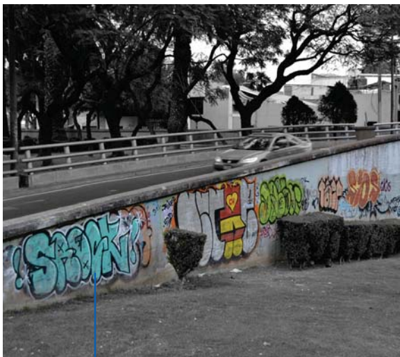
Fachadas en primer nivel-Bombas
