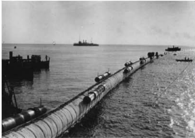
Figura 1.2 Longitud de 2 km para extraer agua fría (tomada de otecnews en línea).
