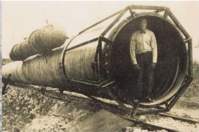
Figura 1.3 Diámetro de 1.6 m para extraer agua fría (tomada de otecnews en línea).
