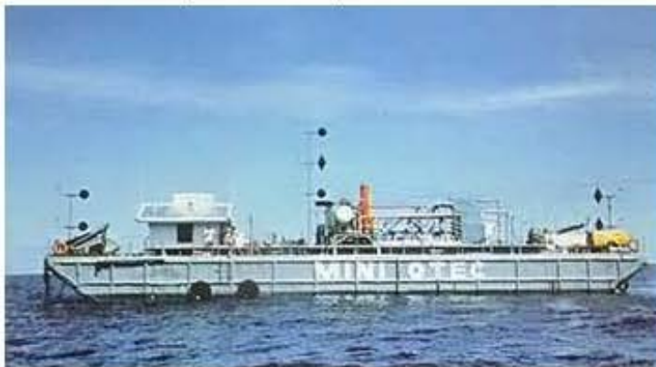
Figura 1.5 Mini-OTEC (tomada de otecnews en línea).
