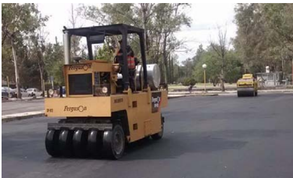
Imagen 19. Compactación de carpeta.
