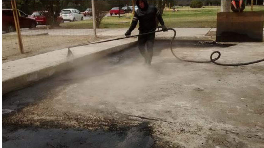
Imagen 17. Aplicación de riego.
