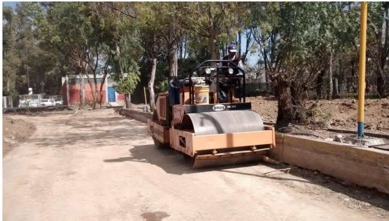
Imagen 12. Compactación por medio de rodillo metálico
