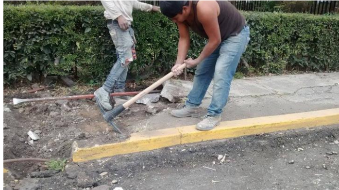
Imagen 26. Demolición de banquetas.
