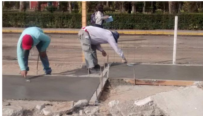
Imagen 24. Colado de banquetas.
