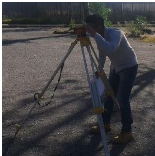
Imagen 3. Nivelación del estacionamiento
