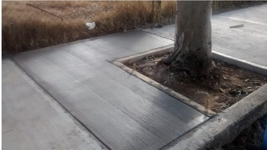
Imagen 27. Colado de arriates.
