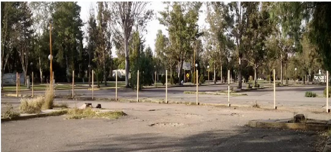
Imagen 1. Baches en asfalto, tocones y flora en banquetas.
