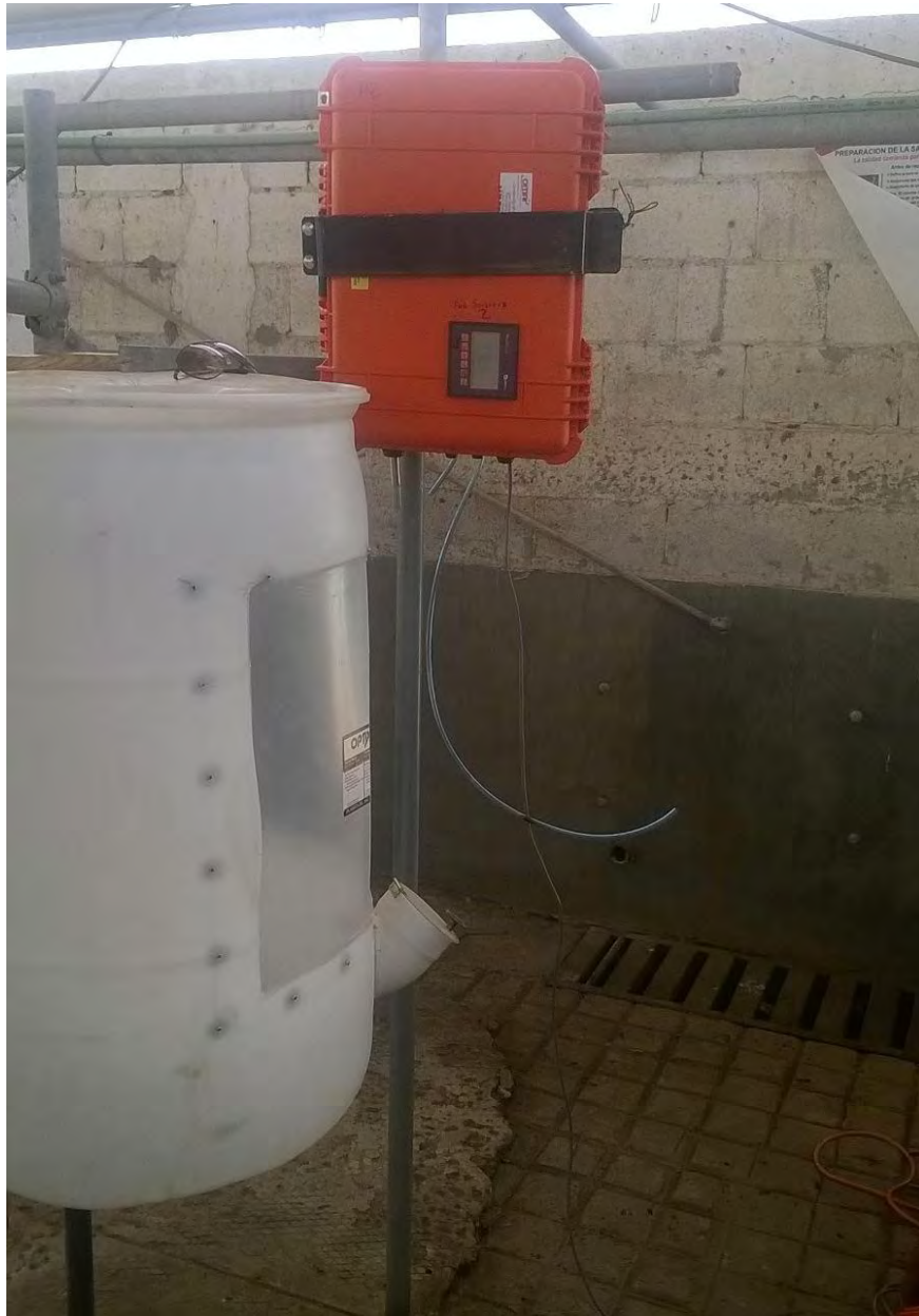
Figura 3. Instalación de Sensor Guardian Plus y adaptación de comedero en el sistema de Lechería Intensiva.
