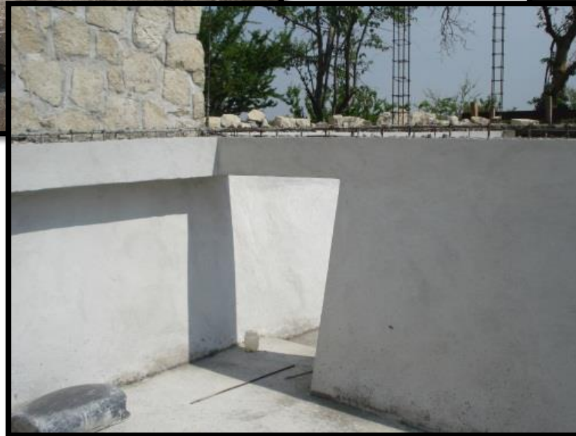
Modificación al proyecto, construcción de bodega subterránea.
