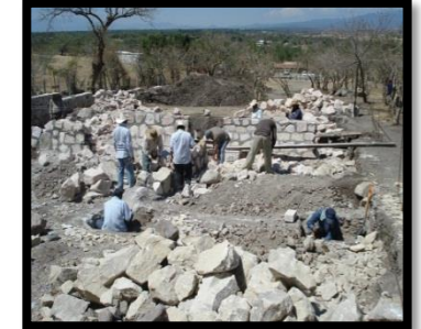
Construcción de cimientos para el área de trabajo
