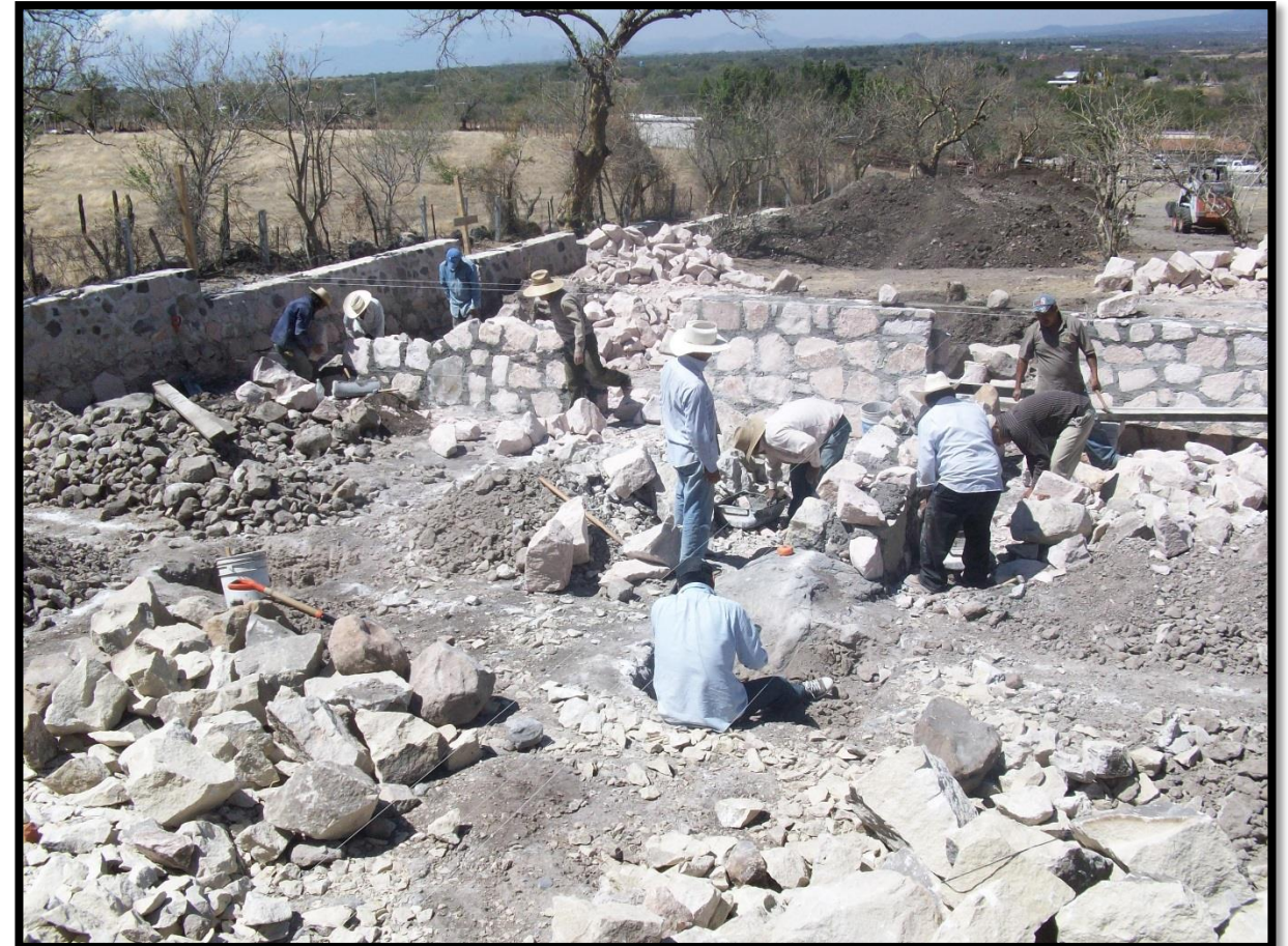
Construcción de cimientos para el área de trabajo.
