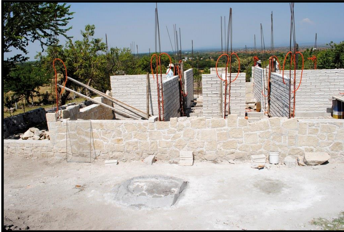
Construcción de muros de block y piedra de cantera, armado de castillos y colocación de mangueras para instalación eléctrica
