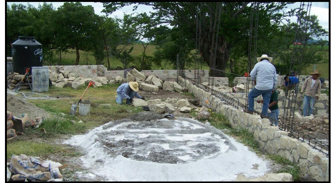
Desplante de muros a base de piedra de cantera y block. Informe Chalcatzingo 2011.
