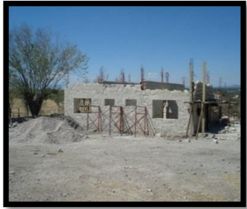
Avance de Obra. Dormitorios
