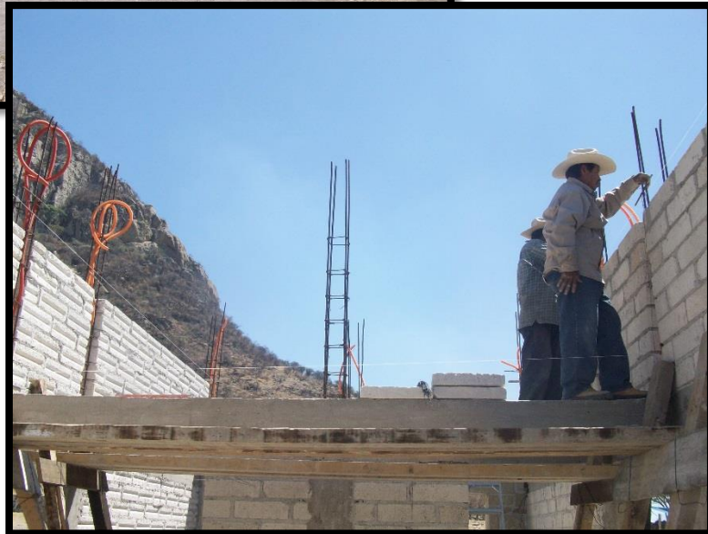
Construcción de muros interiores de Block para el área de dormitorios.
