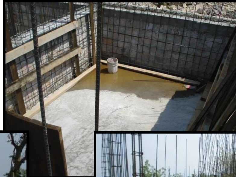
Construcción de cisterna
