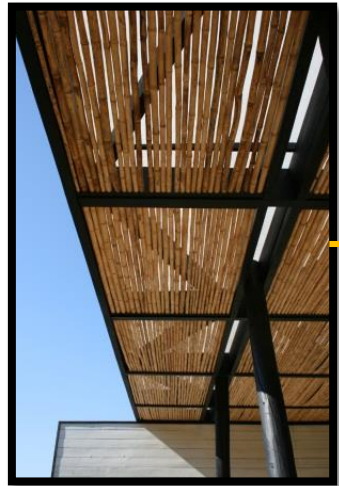
Estructura portante de acero para cubierta de carrizo
