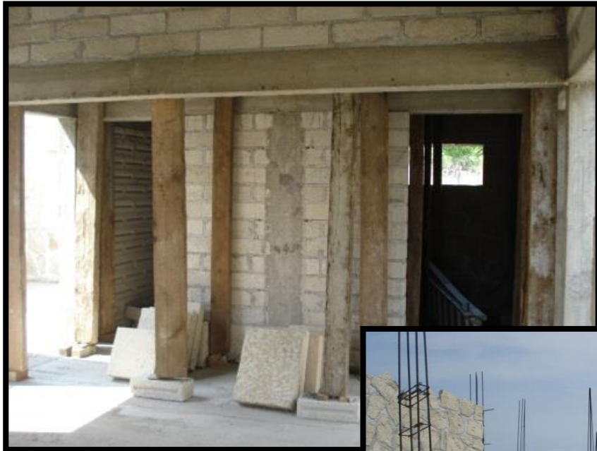
Vestíbulo de área de dormitorios construido en un 80%
