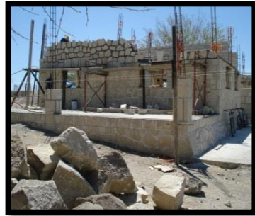
Avance de obra. Corredor o área de descanso.
