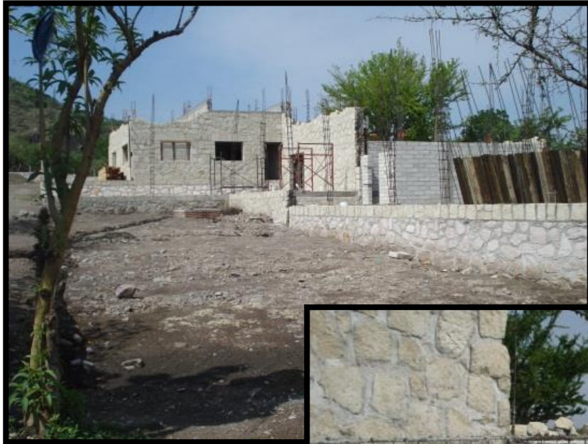
Vista de avance de obra del área de trabajo.
