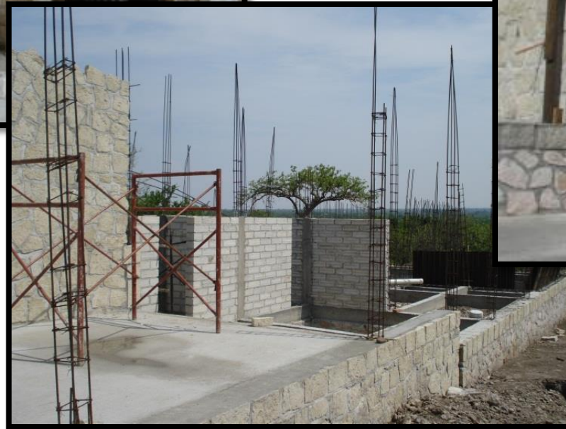
Construcción del área de trabajo
