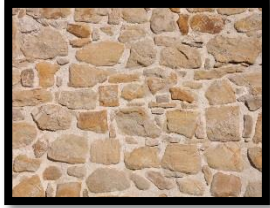
Muro de cantera.
