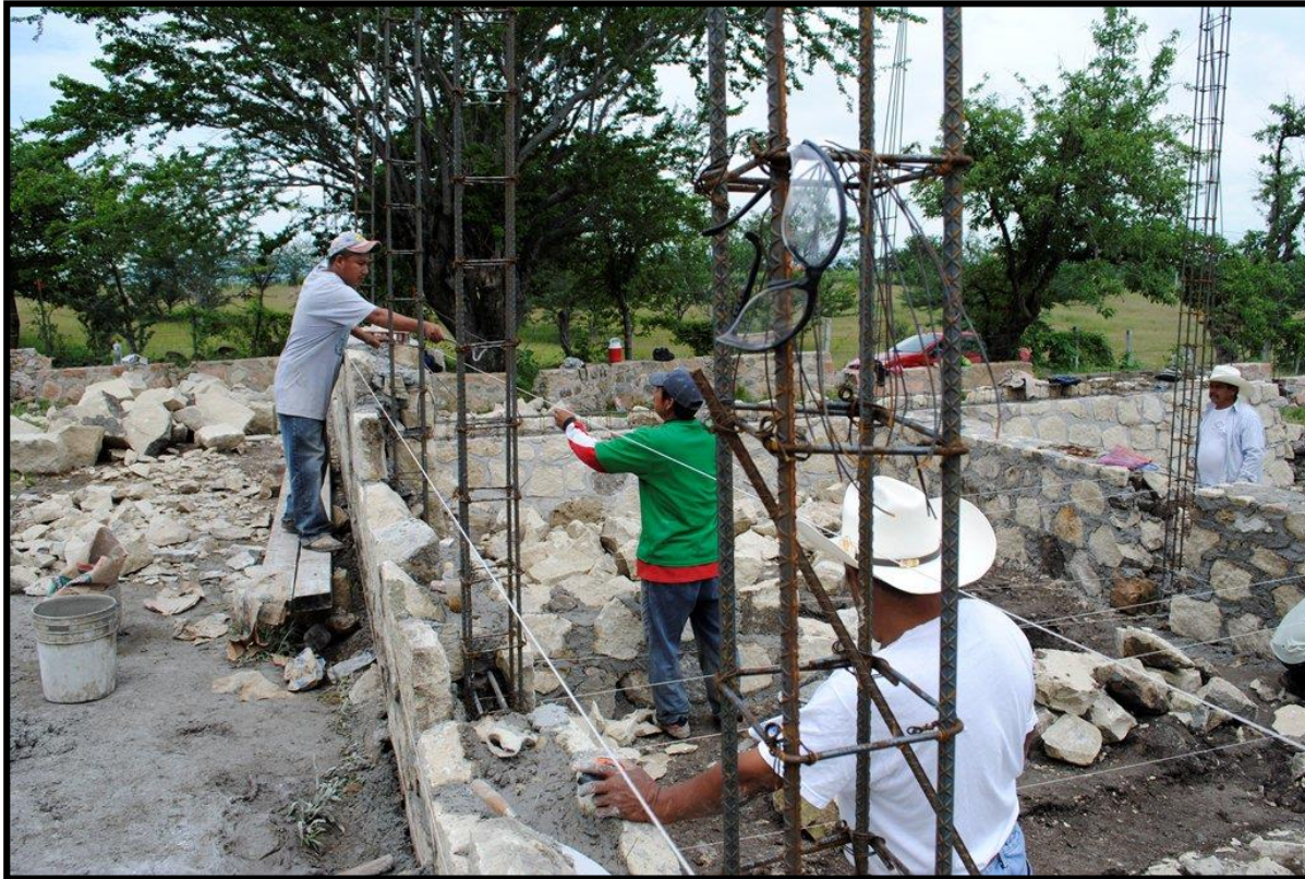
Construcción de muros y armado de castillos de la Unidad de Investigación. Informe Chalcatzingo 2011
