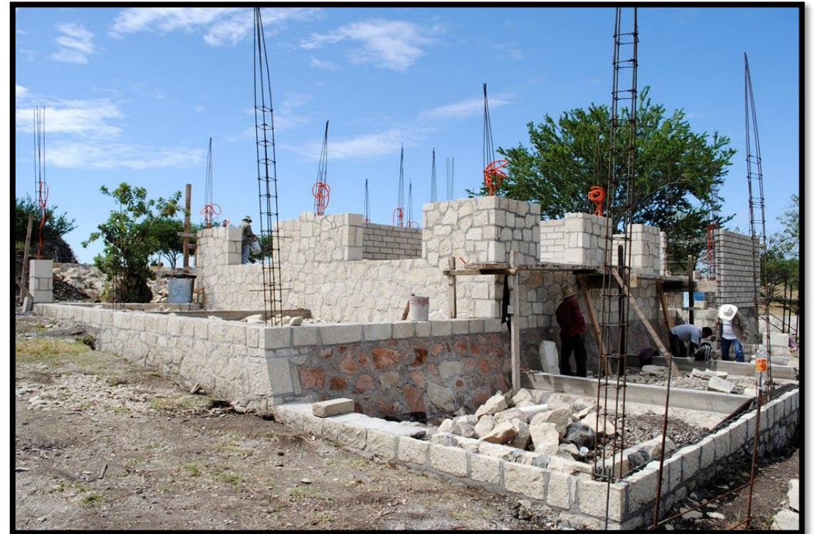
Desplante de muros del área de corredor y construcción de los muros de los dormitorios.
