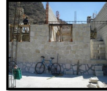
Avance de obra. Área de dormitorios
