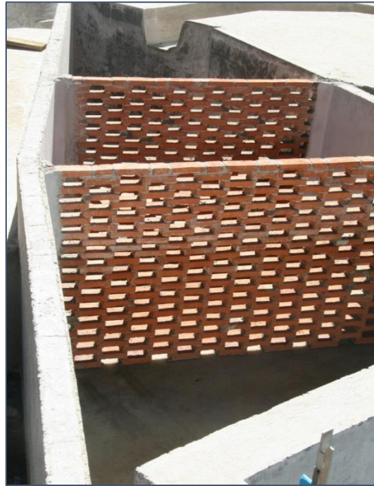
Figura 3.4.5. Construcción de los disipadores de energía
