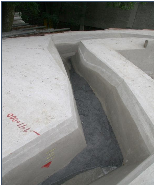
Figura 3.6.3.2. Formación del hombro en la sección 141+000
