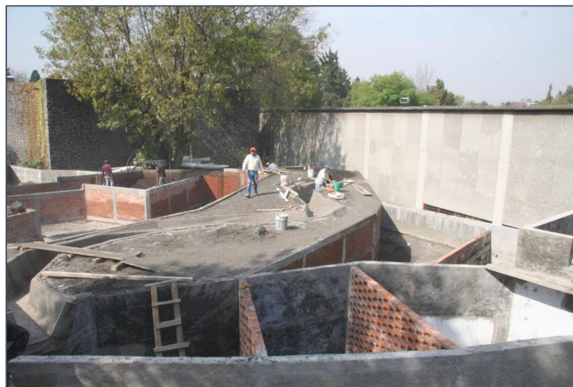
Figura 3.4.4. Colocación de la capa de concreto
