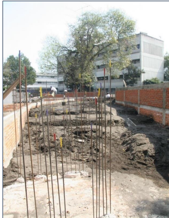
Figura 3.4.3. Colocación de arena
