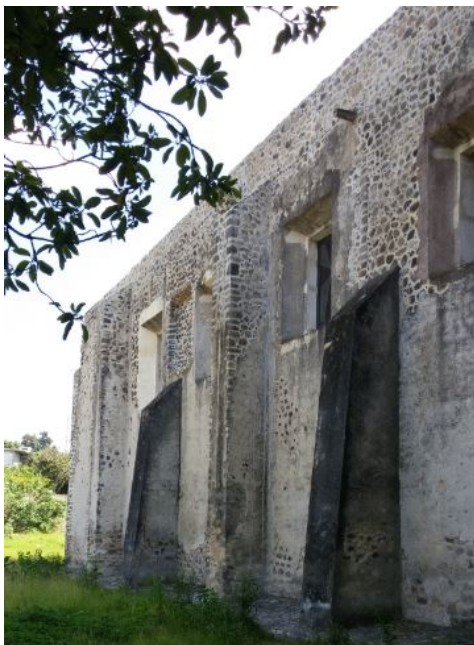
(a) Contrafuertes adosados
