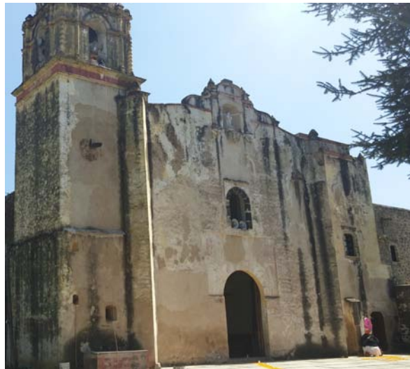
Figura 21: Vista de la fachada principal de Tetela
