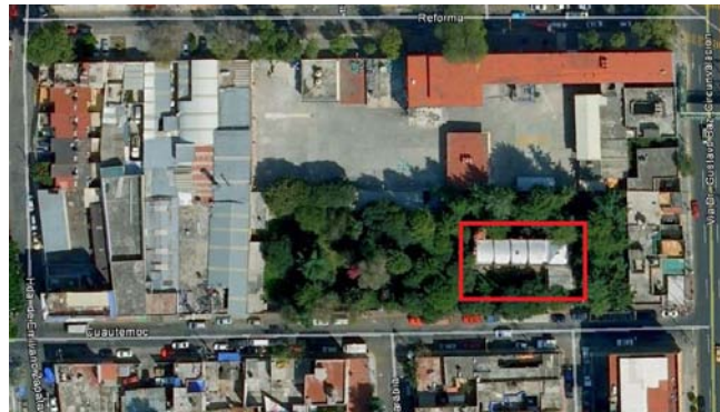
Figura 14: Vista aérea del templo de Nativitas
