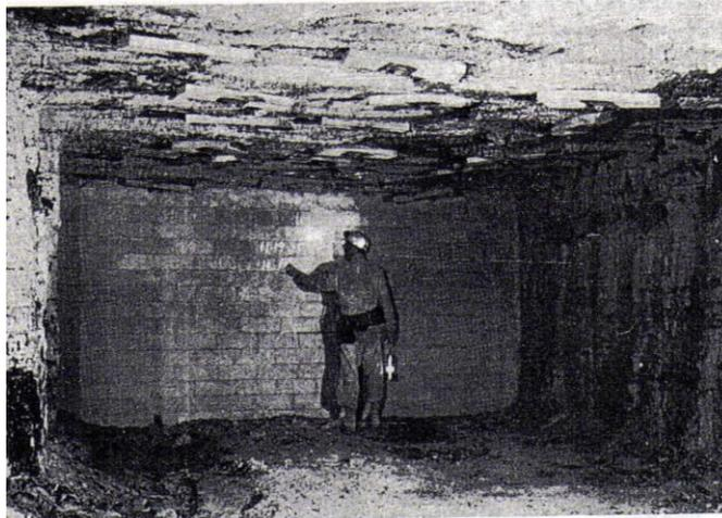
Figura 20: Ejemplo de un muro tipo stopings (Foto)
