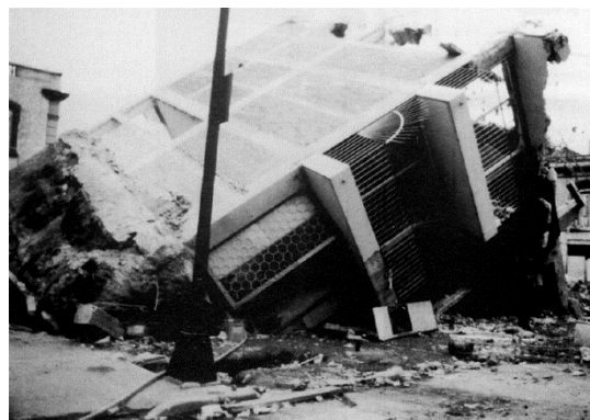
Figura II.9 Falla de cimentación
