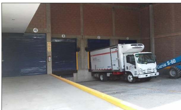
Ilustración 4.4 Andenes de carga y descarga CDIS SODEXO
