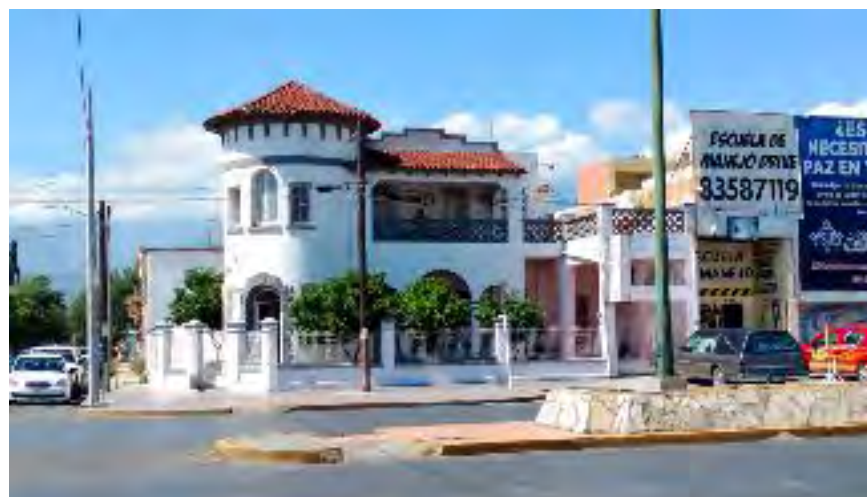
Imagen 7: Casa tipo californiana, ubicada sobre la calzada Madero.
