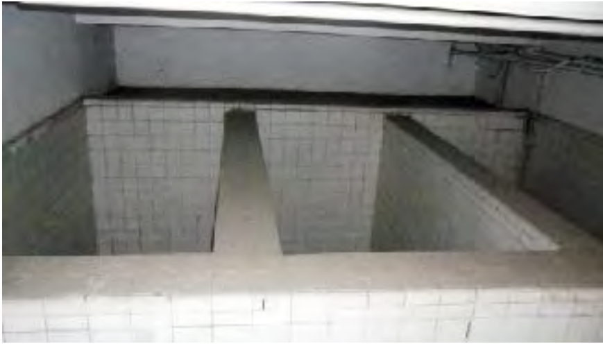
Imagen 23: Tratamiento de agua.
