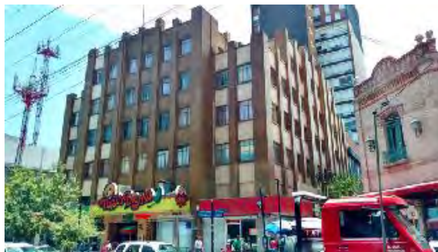
Imagen 8: Edificio la Nacional (1939).
