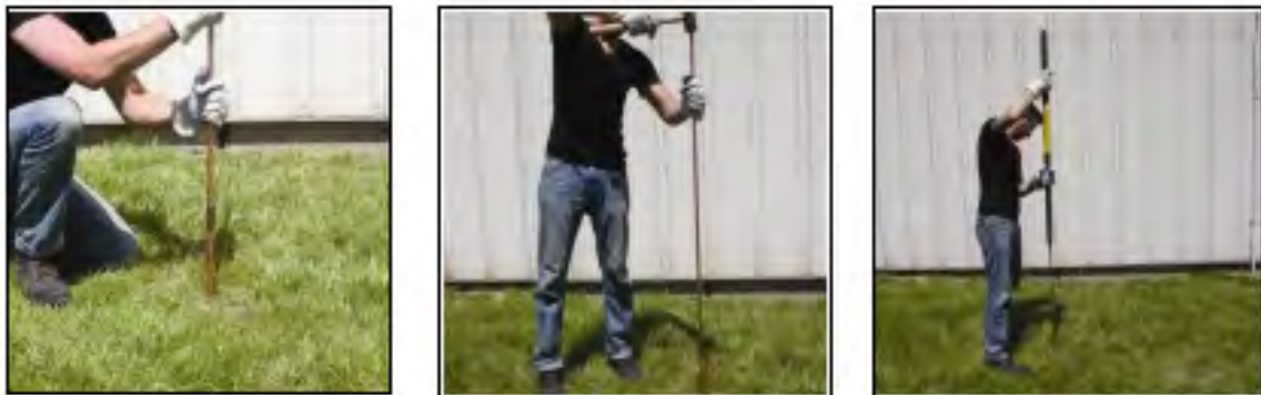
Ilustración 10 Instalación de un electrodo
