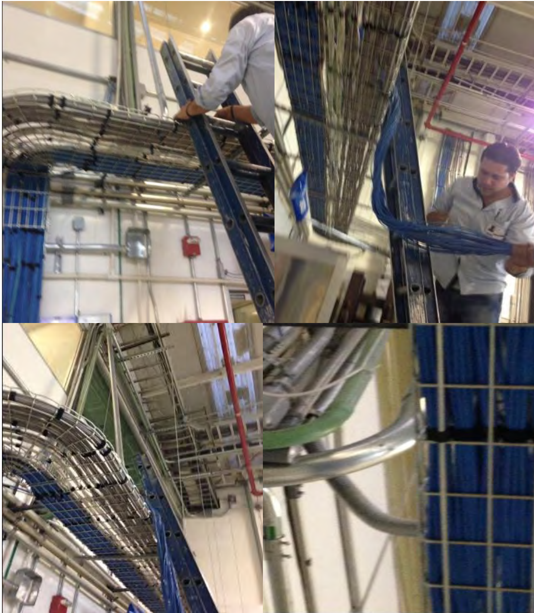
Fotografía 4.1.3 Retiro del cableado en canaletas
