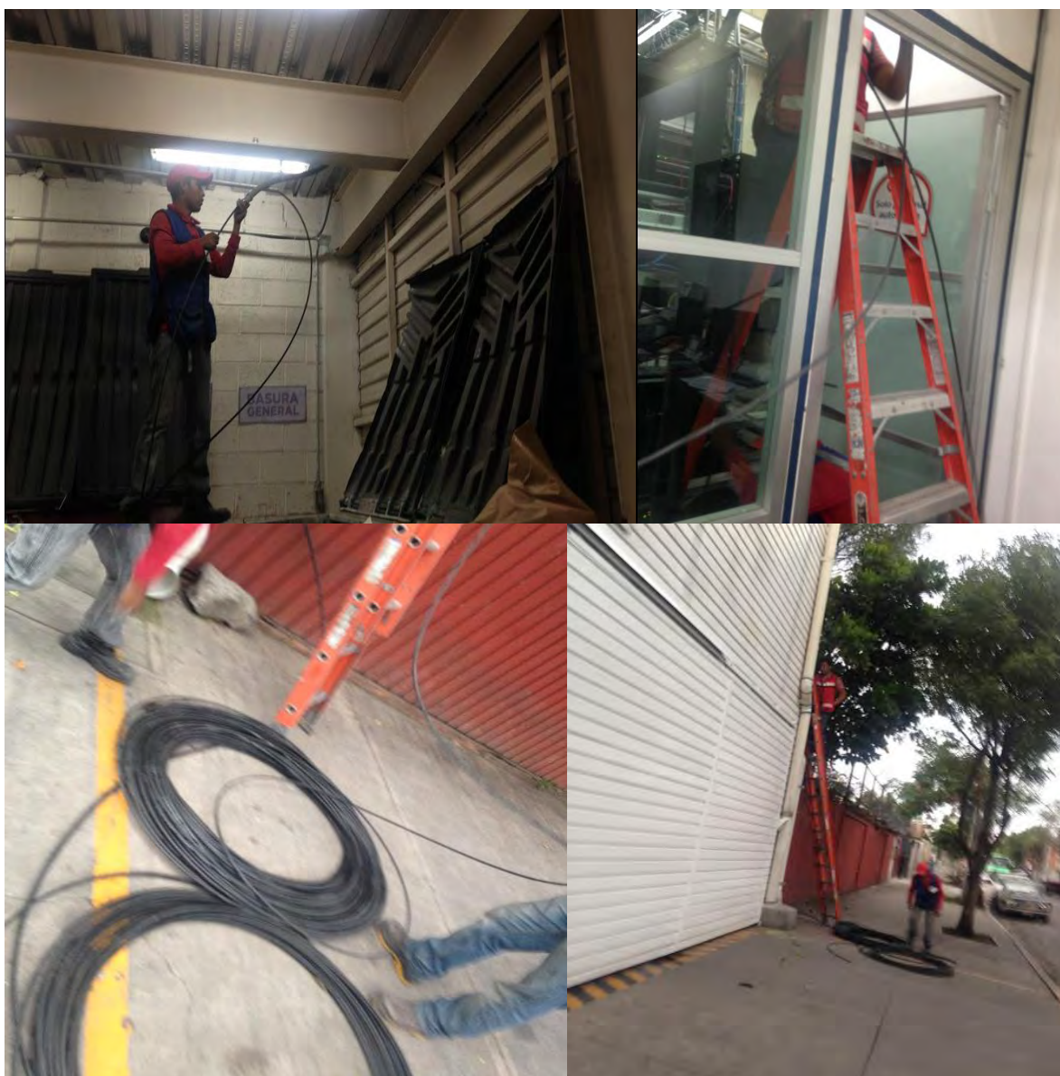
Fotografía 4.2.5b Tendido e instalación de fibra óptica hasta site de nave 3
