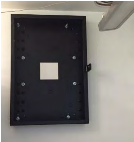
Fotografía 4.2.3a Instalación de soporte
